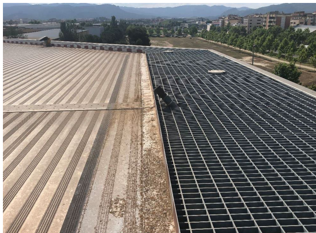
Figura 8. Monitor d'extinció d'incendi de l'heliport
