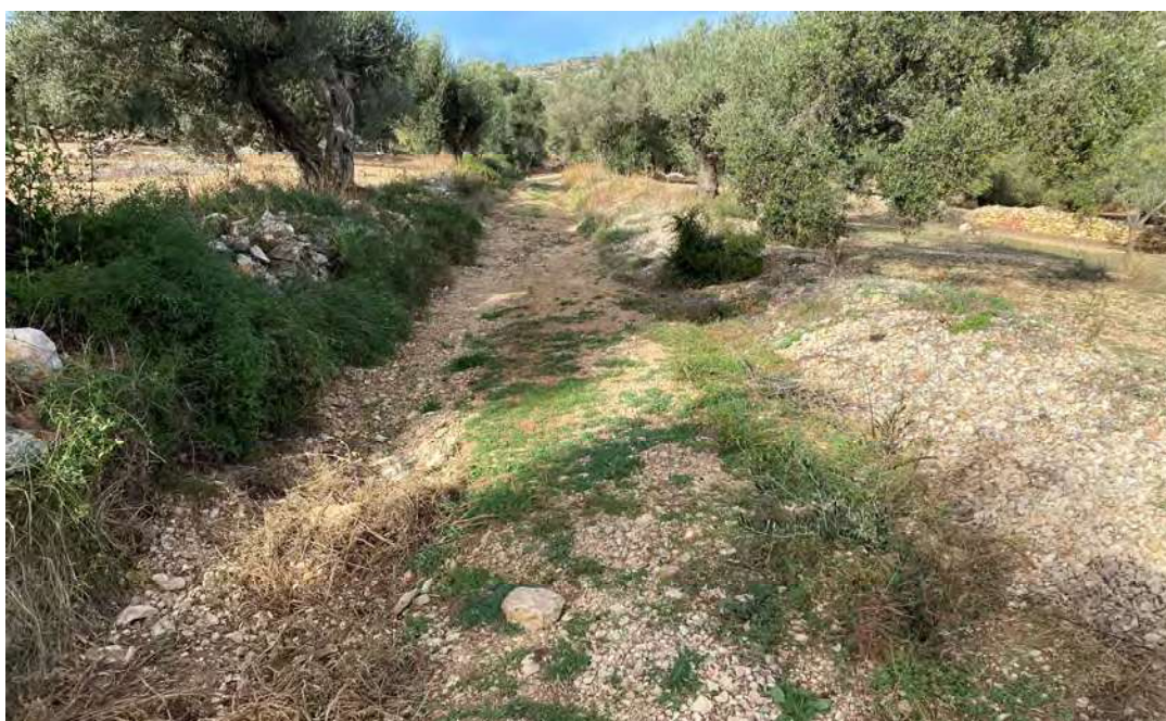
Imatges 3. Desperfectes al camí del Torrilet.
