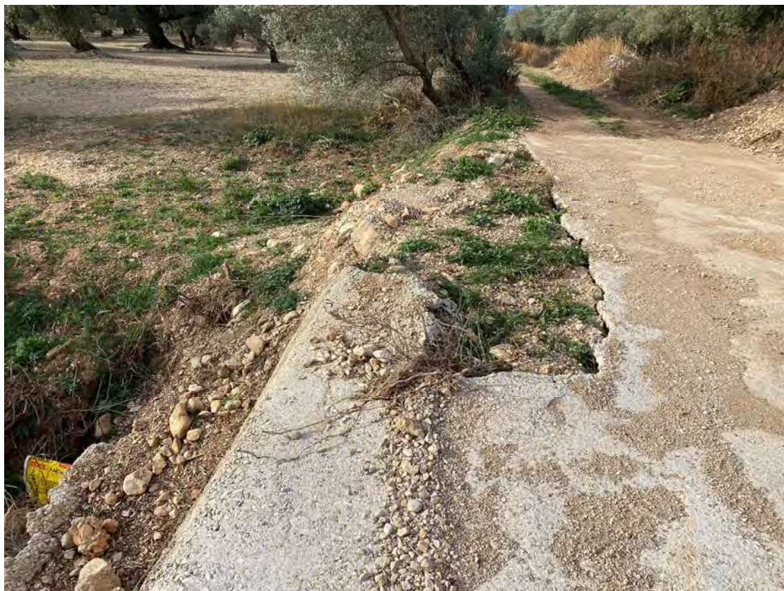
Imatge. Reparació provisional amb terres de la solsida
