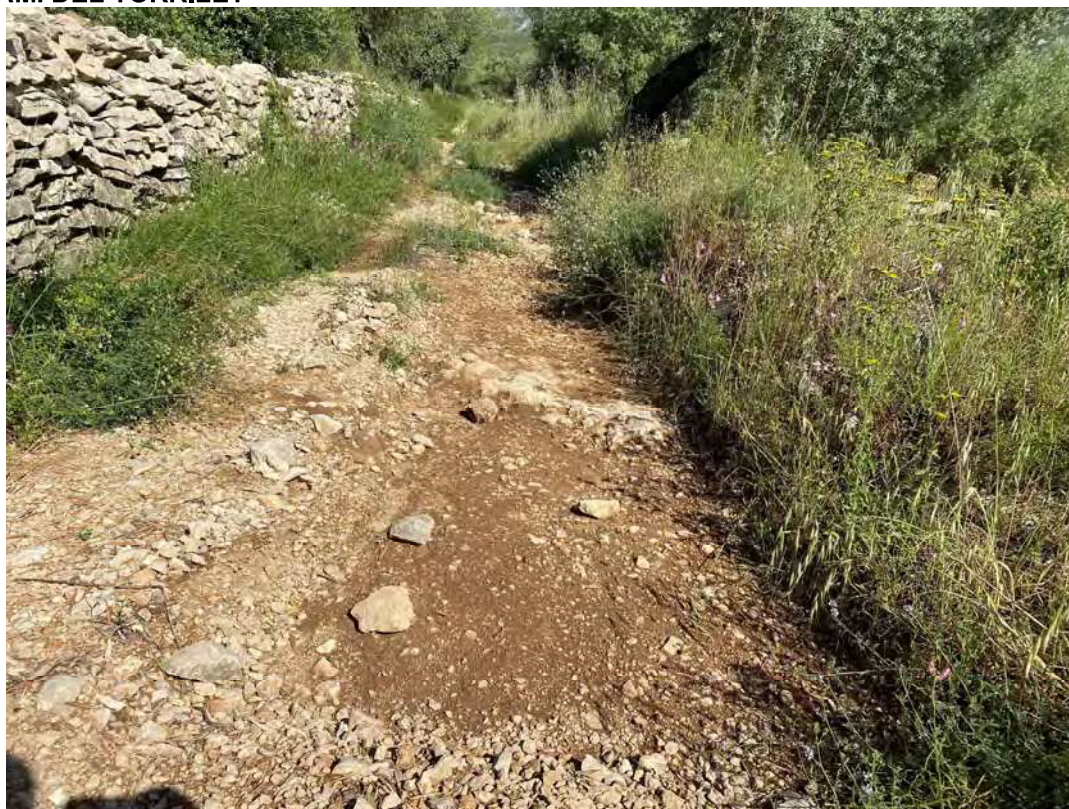
Imatge. Reparació provisional amb terres de la solsida
