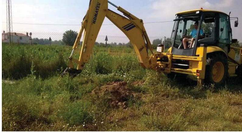
Emplazamiento de máquina en el Calicata C-01.
