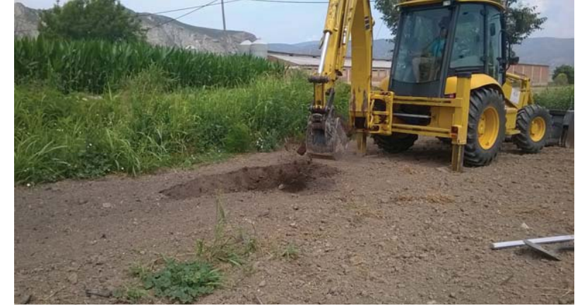
Emplazamiento de máquina en el Calicata C-02.
