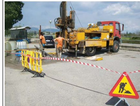
Emplazamiento de máquina en el sondeo S-02.
