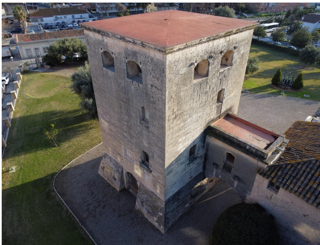
Figura 24. 2024 – Façanes nord-est i nord-oest (l'autor del projecte).
