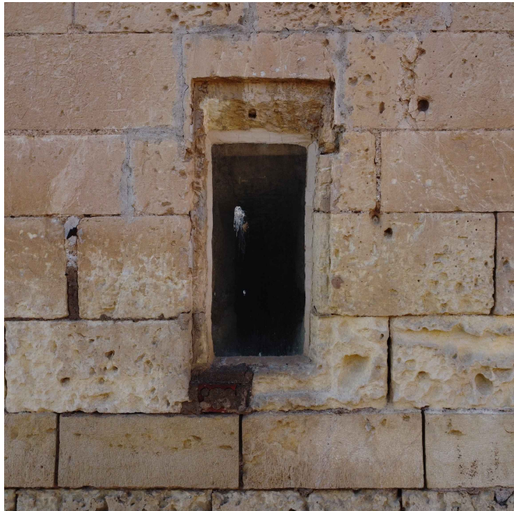
8. Finestra d'espitllera ampliada a la façana sud-est.
