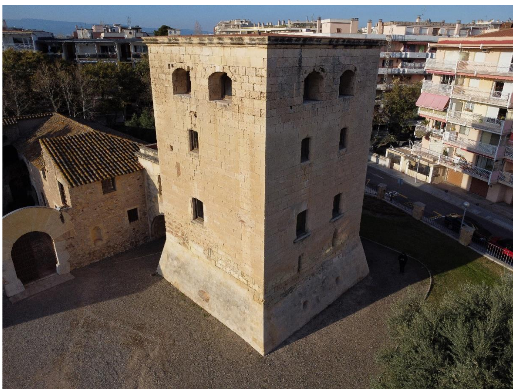
Figura 22. 2024 – Façanes sud-oest i sud-est (l'autor del projecte).
