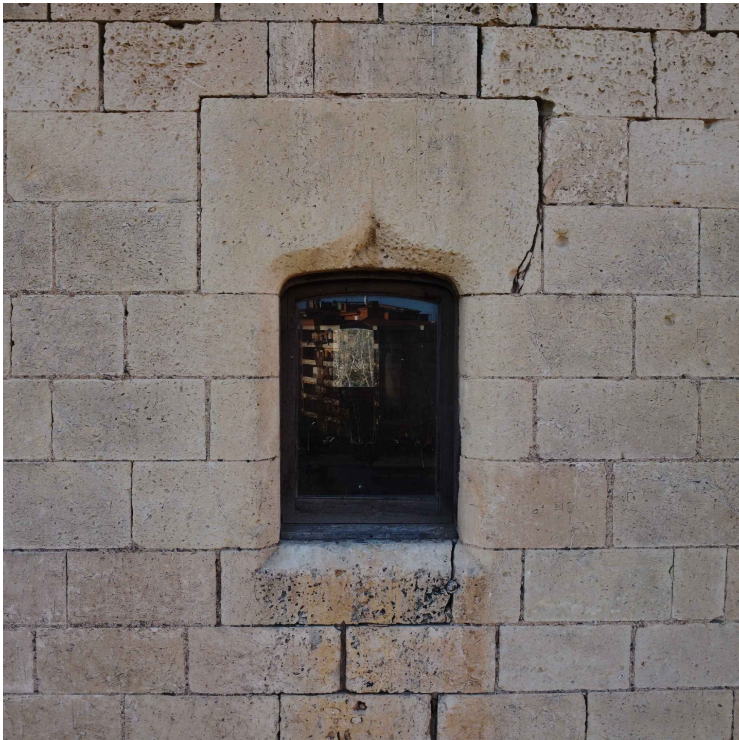
10. Finestra amb arc conopial esmotxat, sense ornamentació, amb llinda d'una peça i sense llosana de pedra, situada al nivell 2 de la façana sud-est.
