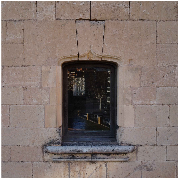
9. Finestra amb arc conopial esmotxat, lleugerament ornamentat, amb llinda de 3 peces i llosana de pedra, situada al nivell 1 de la façana sud-est.
