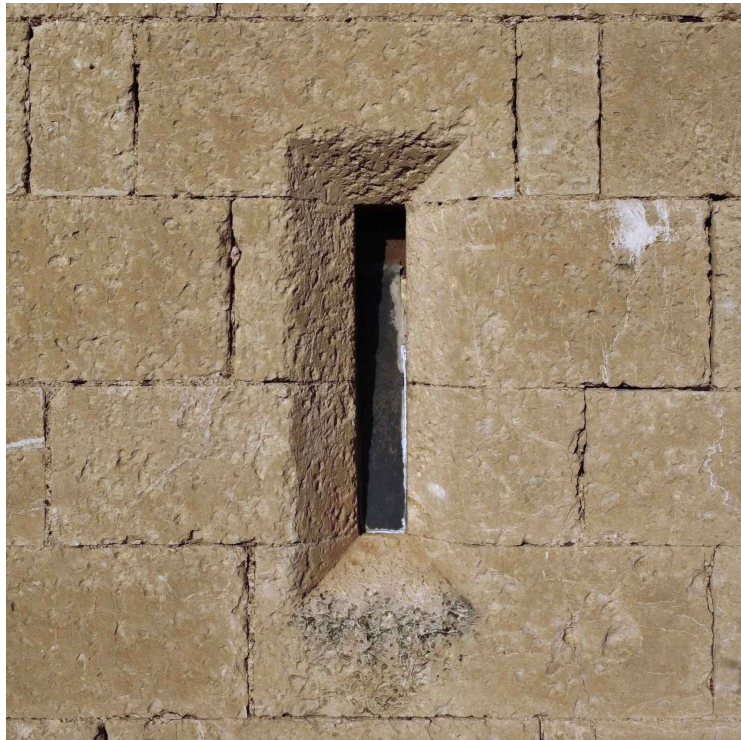
7. Finestra d'espitllera a la façana sud-oest.
