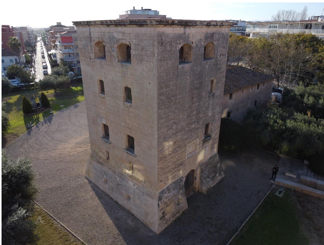
Figura 21. 2024 – Façanes sud-est i nord-est (l'autor del projecte).
