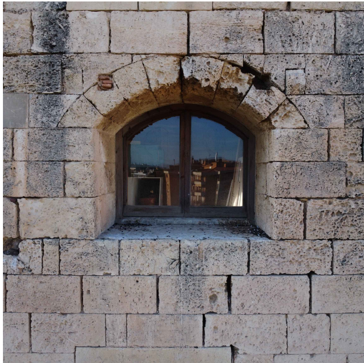
11. Finestra amb arc escarser, situada al nivell 3 de la façana sud-oest.
