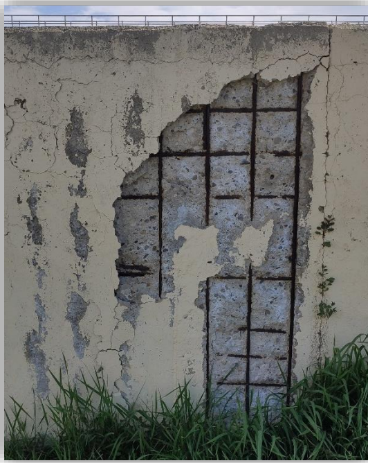
Figura 3. Detall patologia mur exterior.
