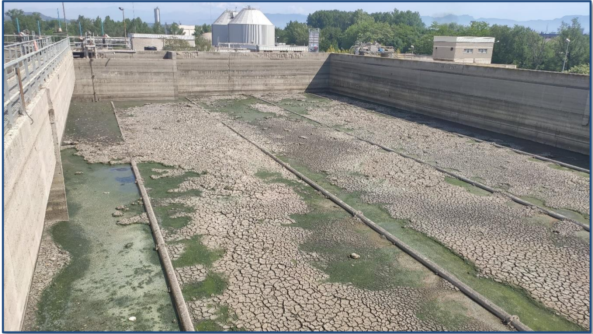
Figura 15. Homogeneïtzador 2 buit
