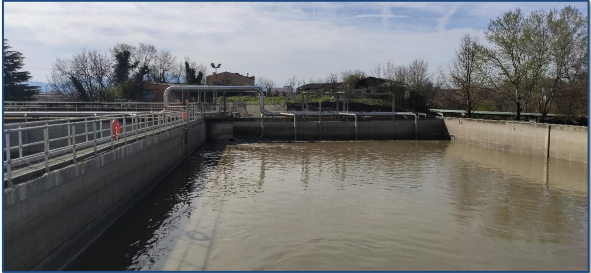
Figura 11. Vista mirant cap al Sud de l'homogeneïtzador 1
