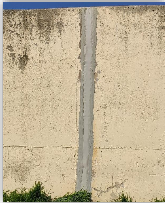
Figura 4. Reparació provisional d'una junta.
