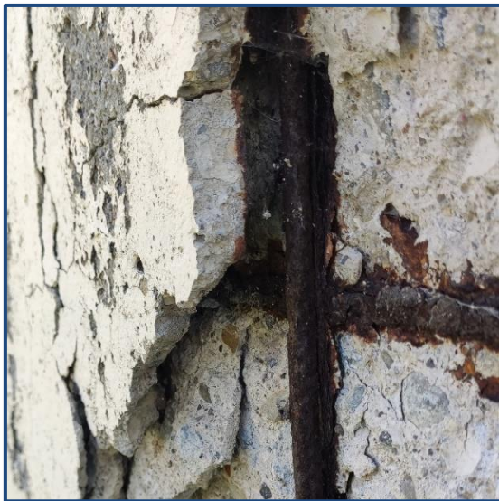
Figura 9. Detall armat aparent
