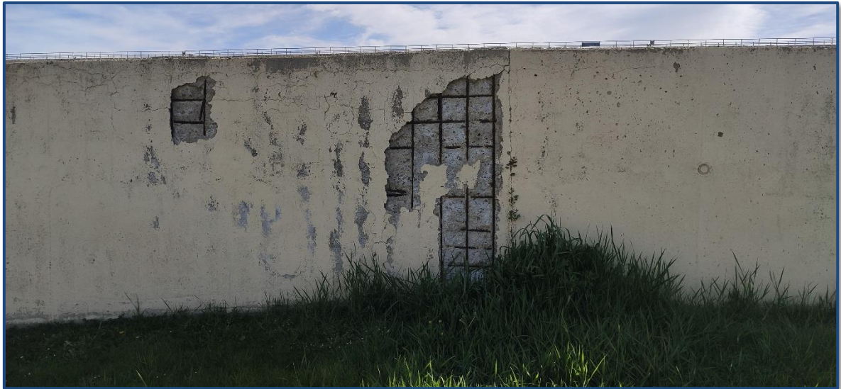
Figura 6. Mur Oest – Detall
