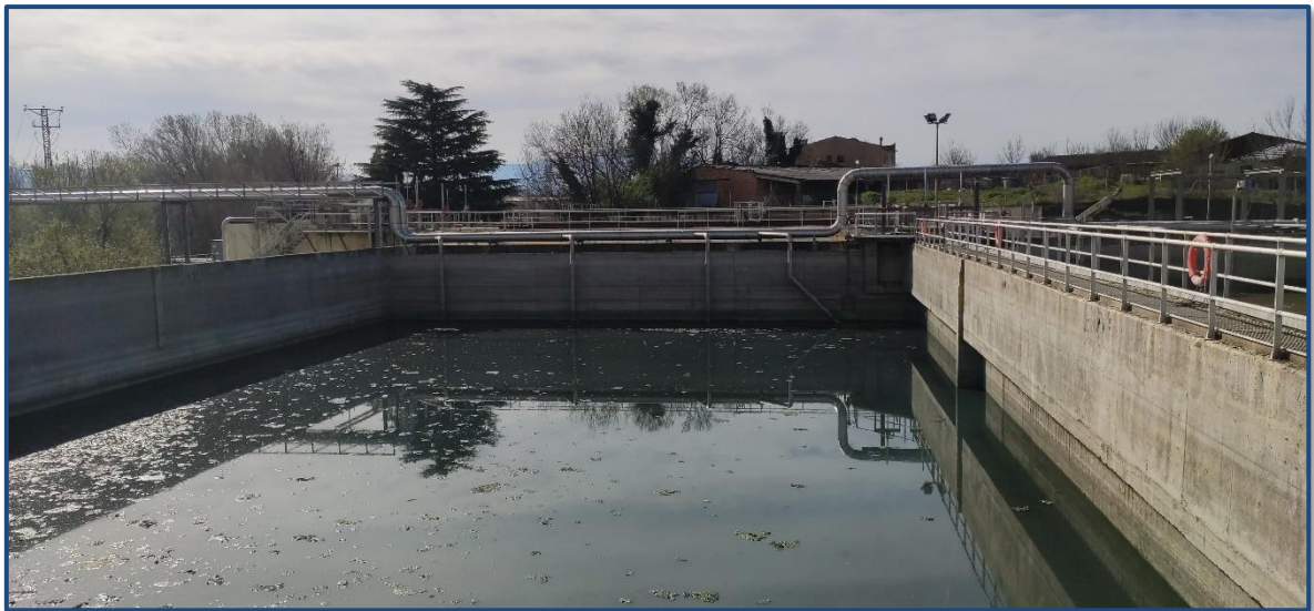
Figura 12. Vista mirant cap al Sud de l'homogeneïtzador 2
