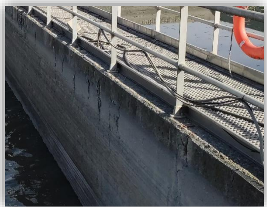
Figura 4. Reparació provisional d'una junta.
