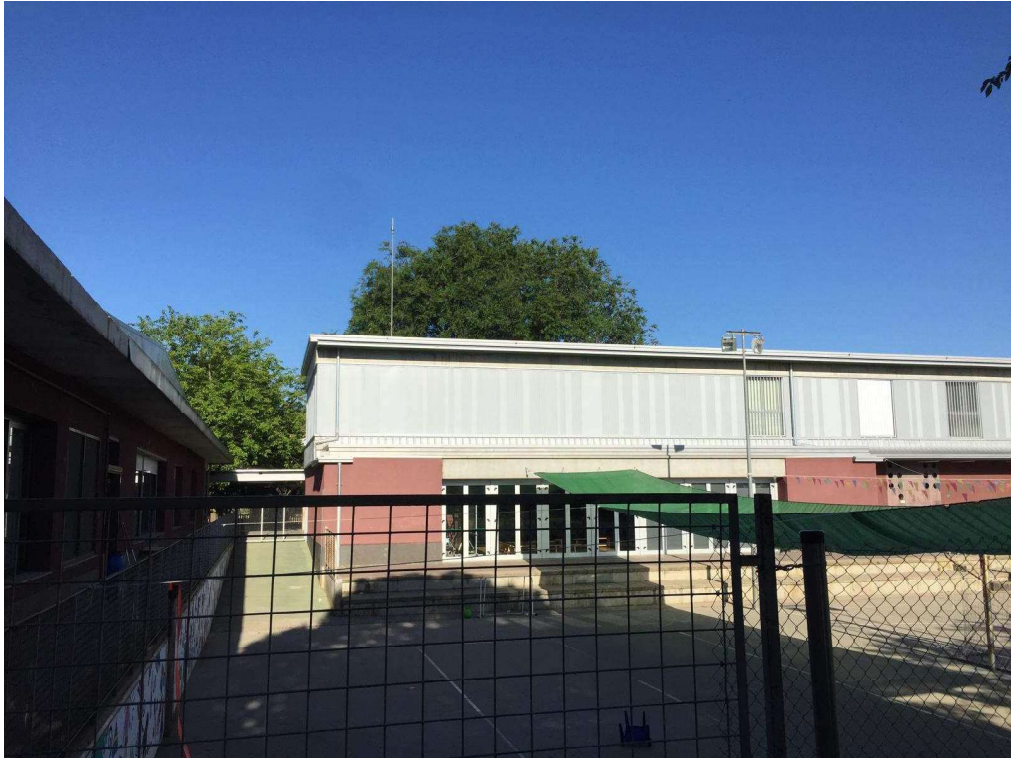
Fotografia 3. Vista de la façana i coberta on s'han previst instal·lar les unitats exteriors
