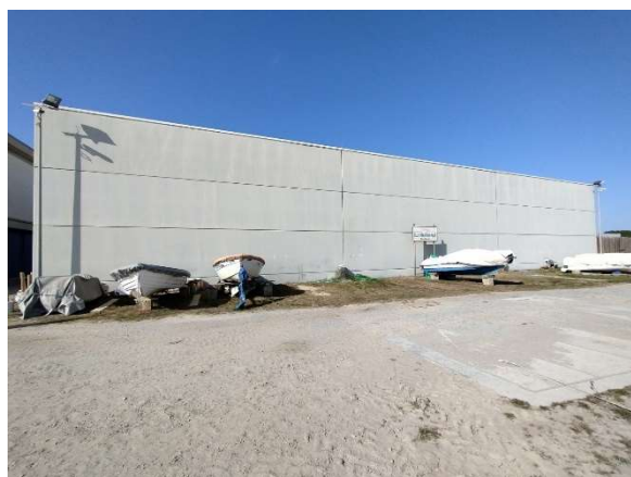
2 - Edifici exterior de captació (Façana mar)
