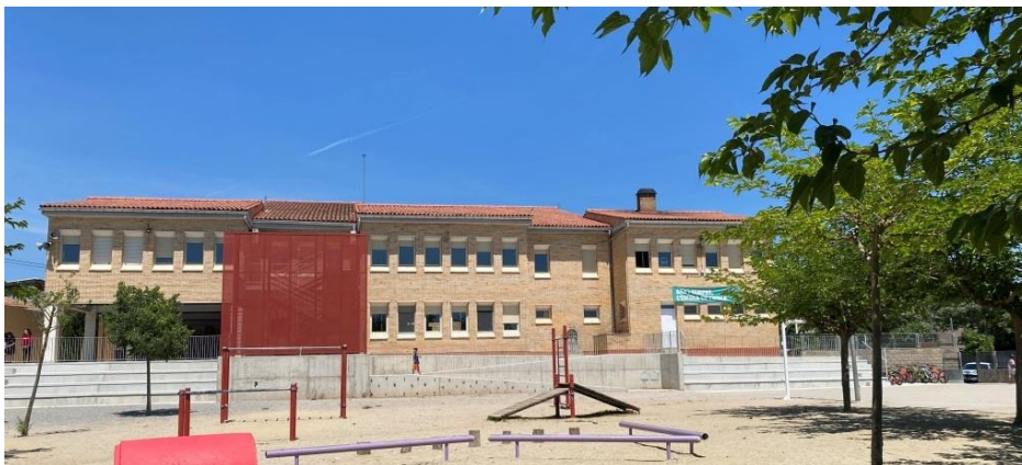
Façana sud edifici primària
