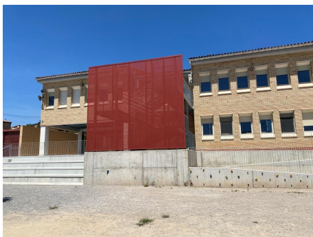
Façana sud edifici primària
