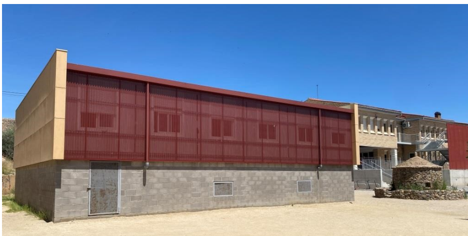
Façana sud edifici secundària
