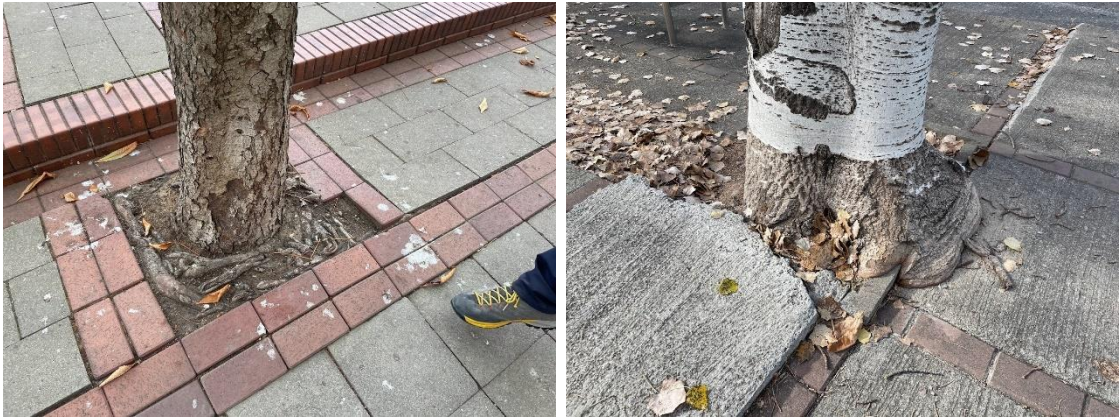
Imatge 12. A l'esquerra, Aesculus hippocastanum amb arrel encastada al carrer del Remei i; a la dreta, Populus alba 'pyramidalis' amb creixement del tronc per sobre del paviment a l'eix 11 de setembre.
