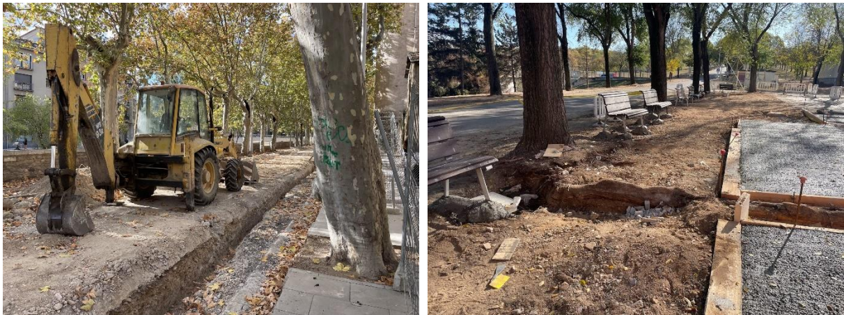
Imatge 13. Dues imatges d'obres realitzades a l'entorn de l'arbrat urbà. A l'esquerra, a la Rambla del Bisbat; i a la dreta, davant l'accés peatonal del pavelló de l'Ausoneta.
