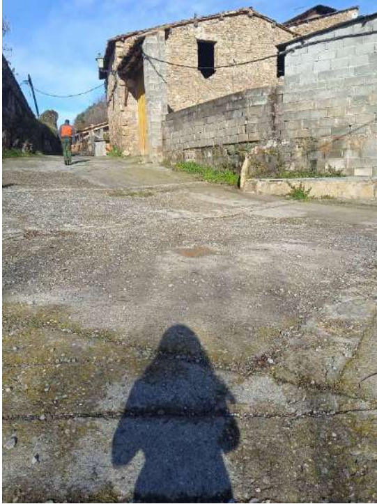
Il·lustració 4: Punt final de pavimentació.
