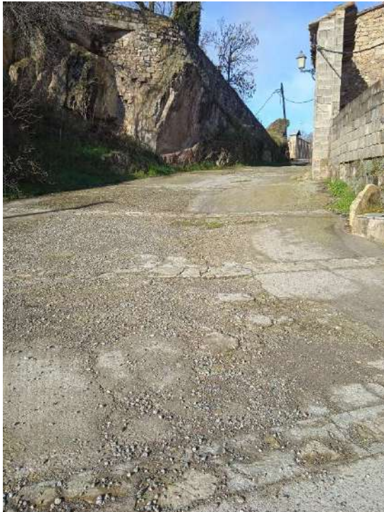
Il·lustració 6: Carrer a pavimentar i instal·lar reixa de captació pluvial
