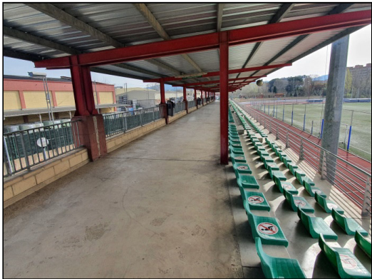
Fotografia 14. Estructura porticada de coberta graderia.
