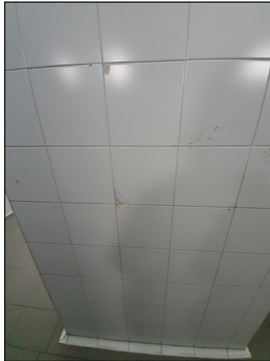
Fotografia 1. Revestiment deteriorat. Fotografia 2. Revestiment deteriorat.
