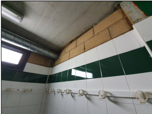
Fotografia 9. Junta no segellada.
