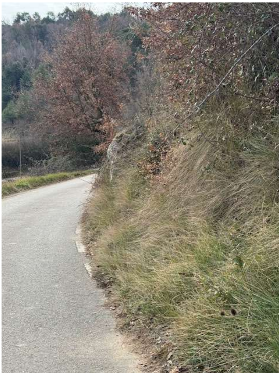
Tipus de terreny que s'ha d'excavar per a millora de la visibilitat.
