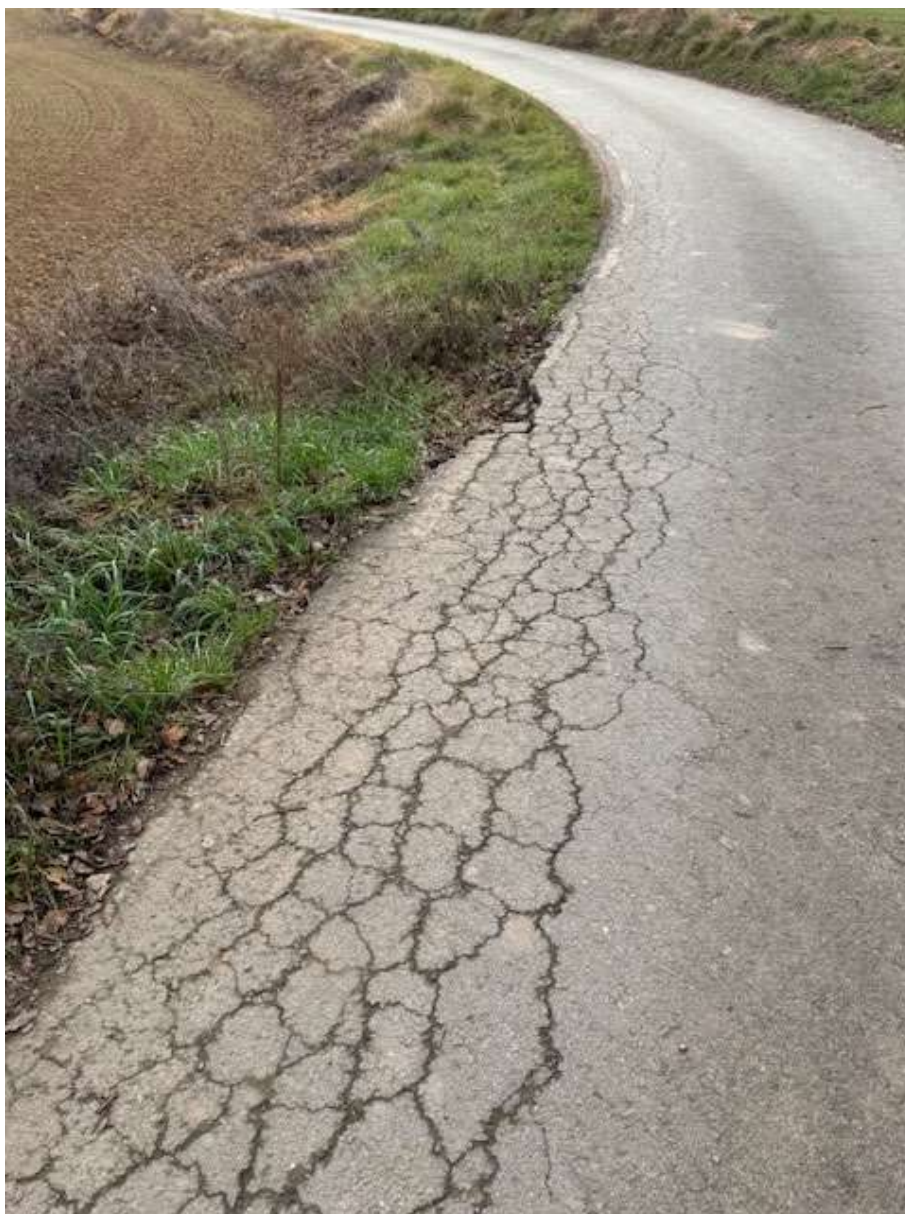
Esquarteraments típus, que es reparen.
