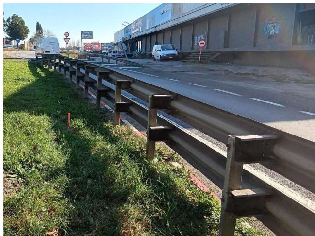
Imatge 14. Replanteig a zona de mitjana
