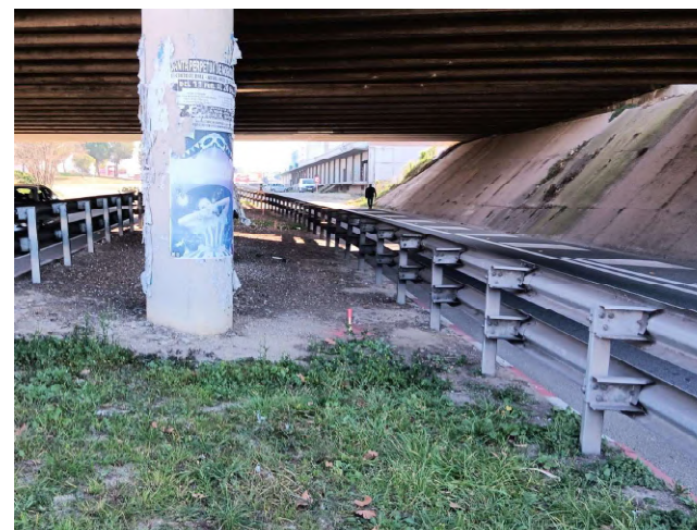
Imatge 12. Replanteig sota el pont
