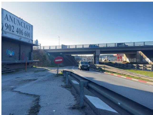
Imatge 2. Vista del lateral i el pas inferior
