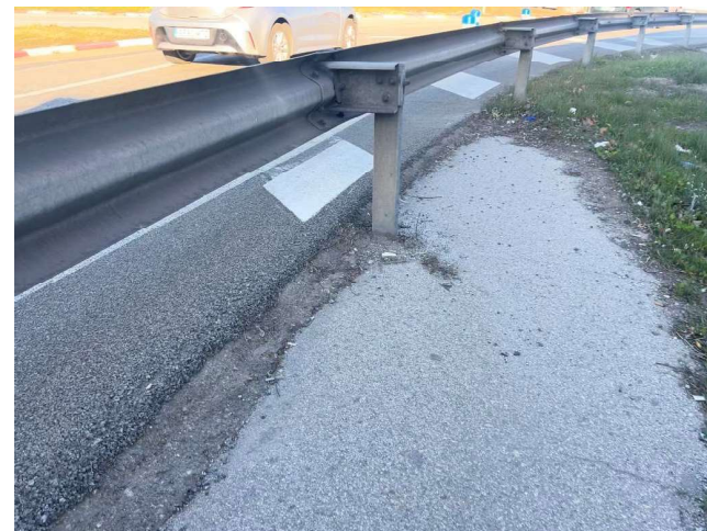
Imatge 3. Detall bionics existents
