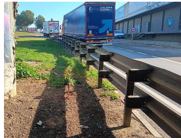
Imatge 11. Replanteig nova caixa de paviment
