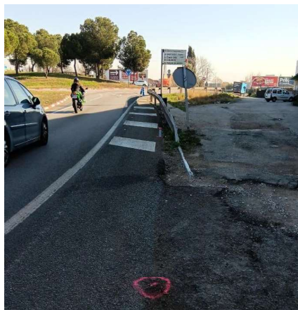
Imatge 13. Replanteig costat dret
