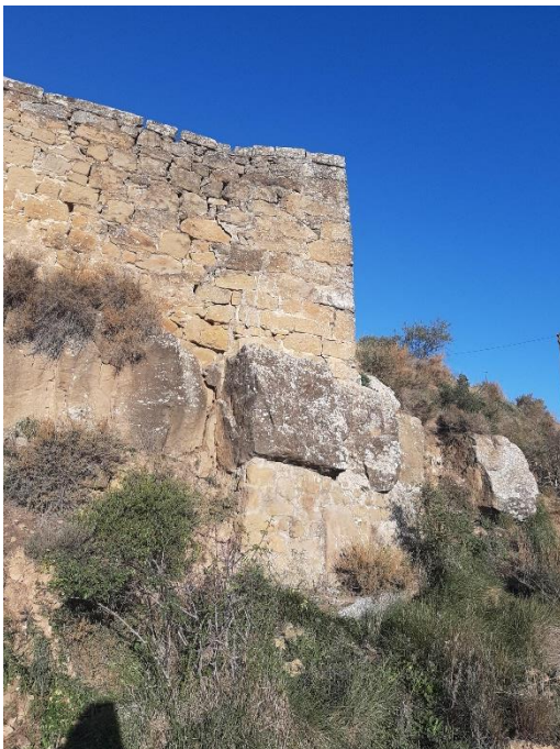
Vista de l'extrem est del mur recolzat en un bloc que a la base presenta una base de mur fet de pedra que s'interpreta que s'ha realitzat per a evitar o aturar l'assentament del mur ( fotografies 10 i 11) .
