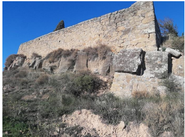
Vista de l'extrem est del mur recolzat en un bloc que a la base presenta una base de mur fet de pedra que s'interpreta que s'ha realitzat per a evitar o aturar l'assentament del mur ( fotografies 10 i 11) .
