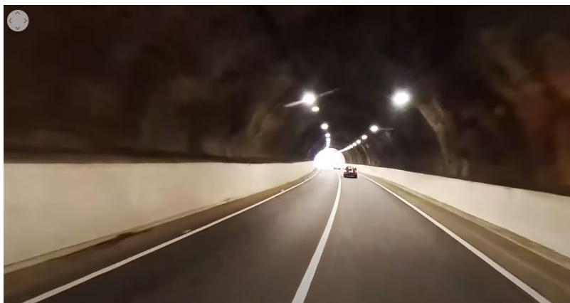
Imatge 1 – Vista Túnel Benifallet
