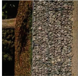
PEDRES DELS GABIONS
