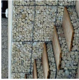
ESCALES AMB GABIONS I FUSTA
