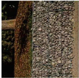
PEDRES DELS GABIONS
