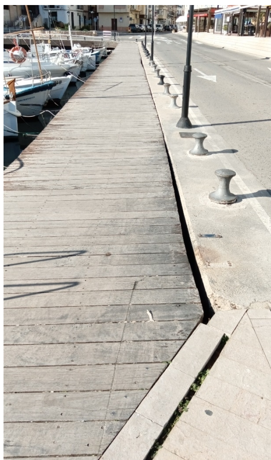
Fotografia 2. Patologia observada a la zona 1, la separació del moll és manifesta en més d'un lloc.
