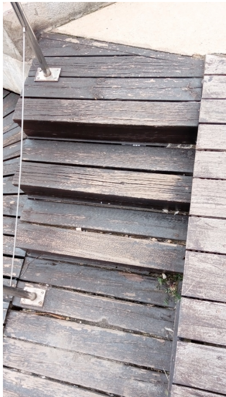
Fotografia 21. S'observa el desgast dels llistons de les escales i com s'han anat separant i omplint de brutícia els buits apareguts.
