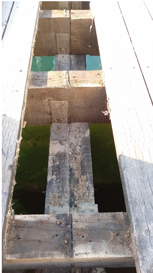
Fotografia 12. Biga transversal i recolzament de les longitudinals.
