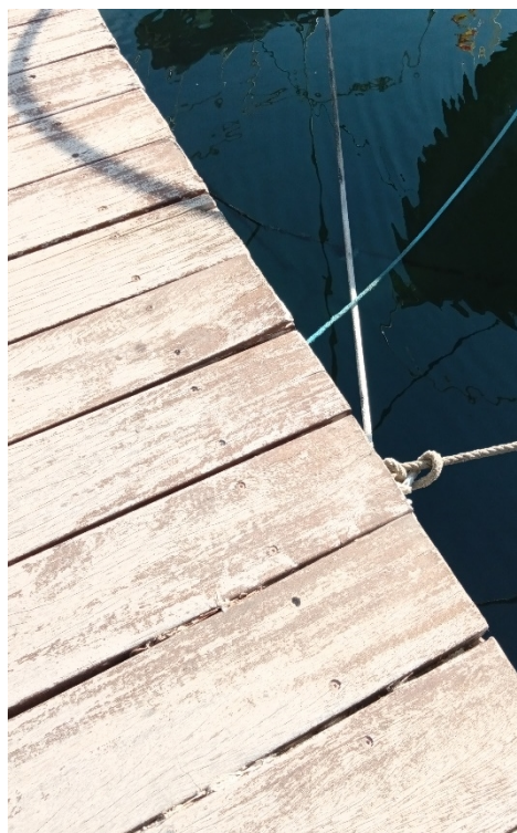
Fotografia 4. Brutícia i desperfectes als extrems dels llistons.
