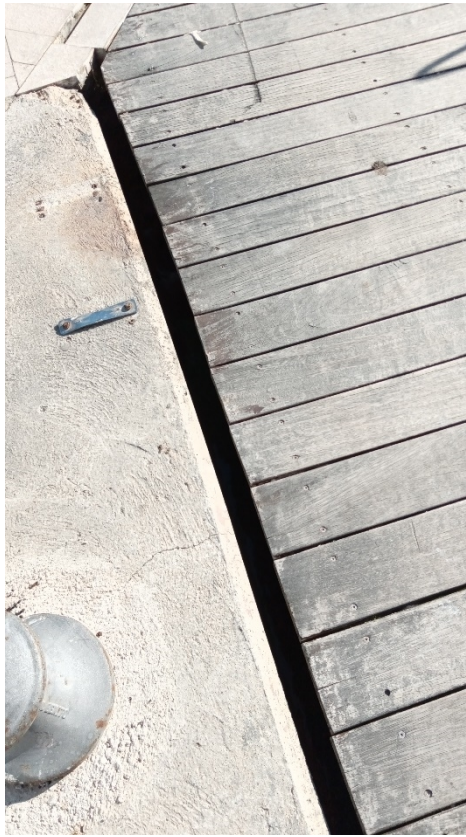
Fotografia 5. La separació és perillosa ja que s'apropa als 10cm.
