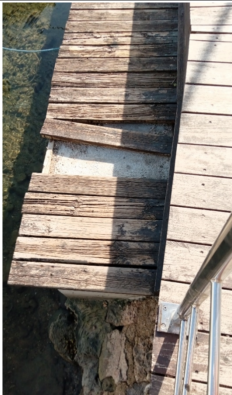
Fotografia 18. Vista general del final de la zona 2.
