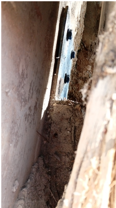
Fotografia 14. Aspecte del recolzament sobre el moll. Aquest deuria ser l'aspecte original de tots els suports.
