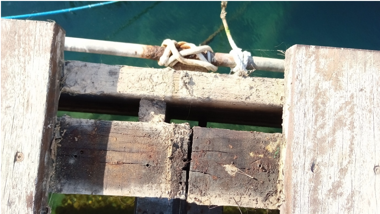
Fotografia 11. Detall de com es sostenen la barra d'amarratge i el remat lateral-
