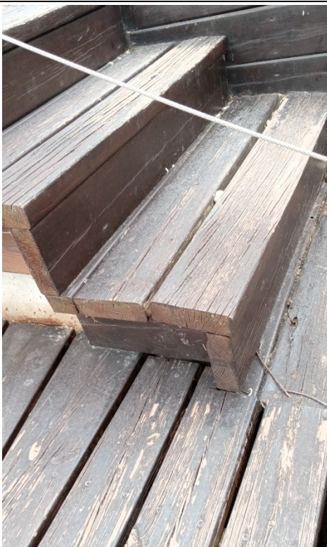
Fotografia 22. Gir evident del darrer esglaó.
