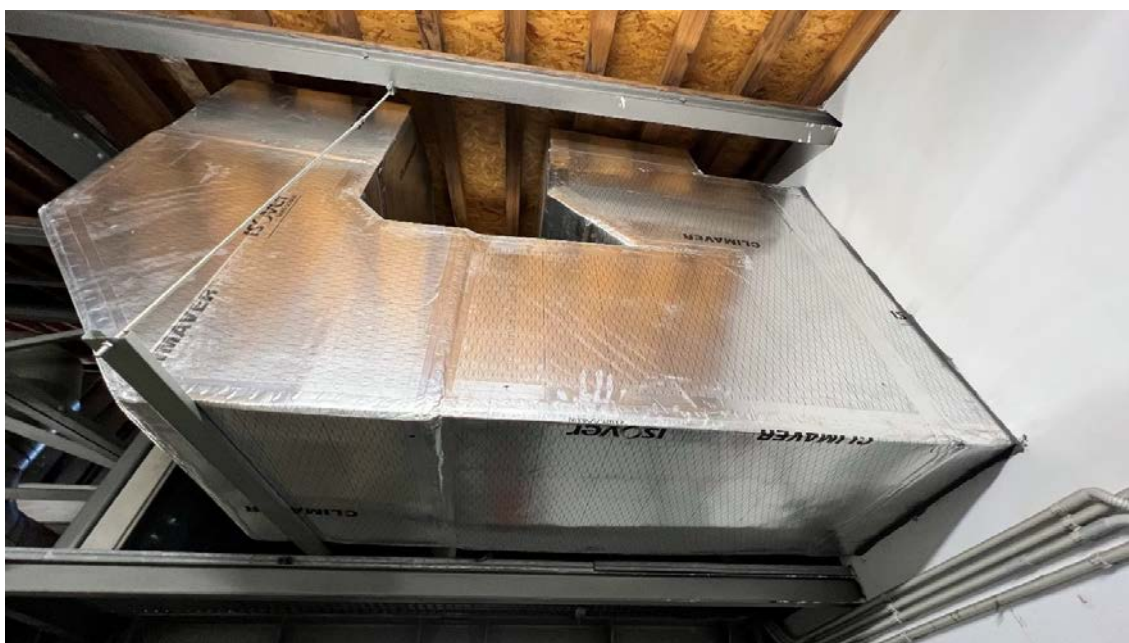
Imatge 2. Conduccions dels equips d'aerotèrmia a l'espai intermedi
