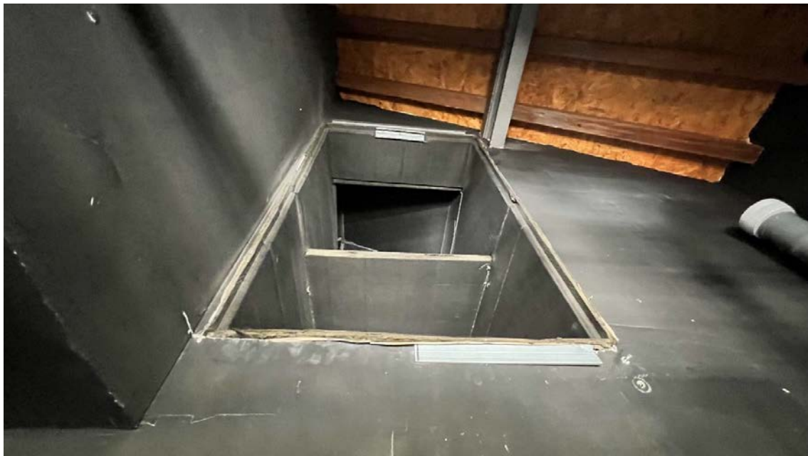
Imatge 3. Sortida d'aire de les unitats d'aerotèrmia a l'espai intermedi
