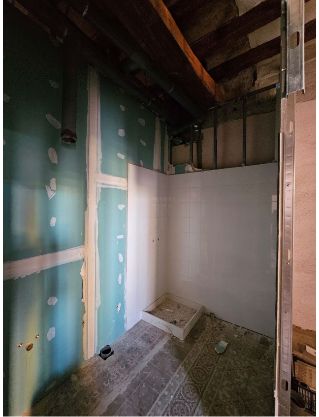
Planta primera. S'observen les obres de rehabilitació iniciades. Rajoles hidràuliques a recuperar
