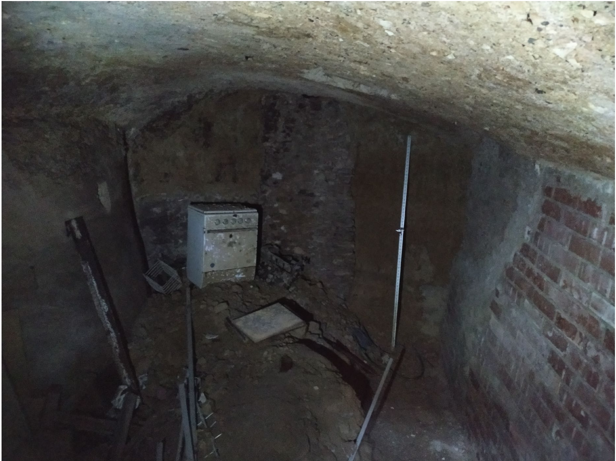
Soterrani existent (fotografia any 2019)
