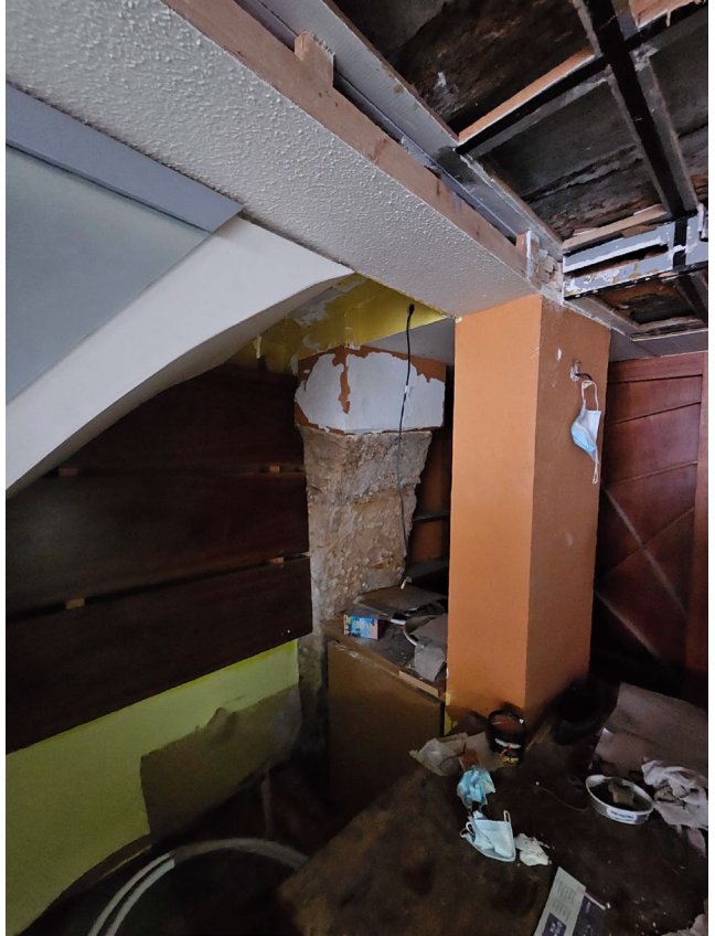
Sostre local a base de cabirons de fusta i arrencada de pilar de pedra a conservar
