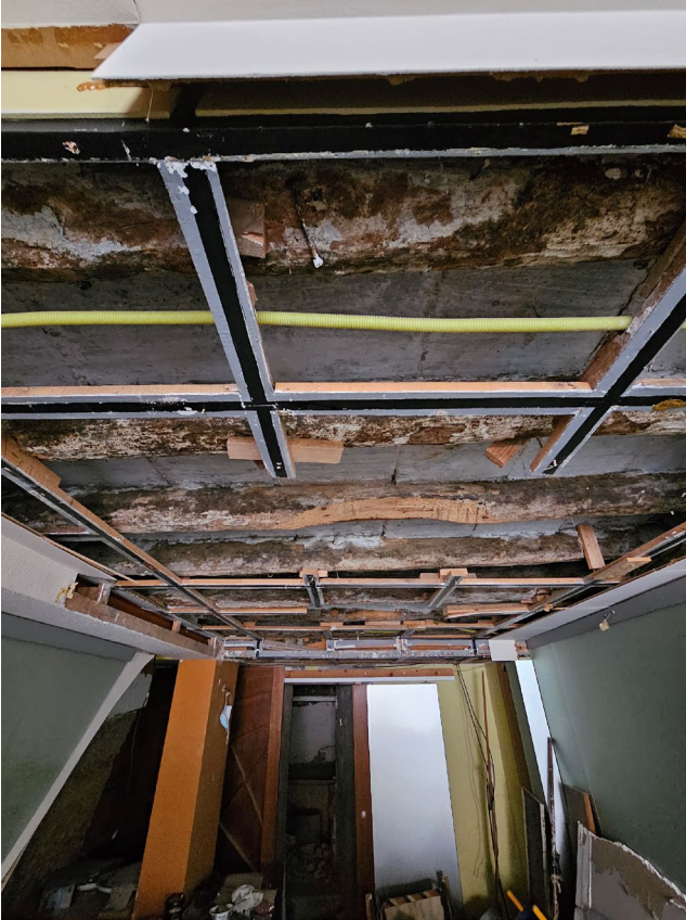
Sostre local a base de cabirons de fusta i arrencada de pilar de pedra a conservar
