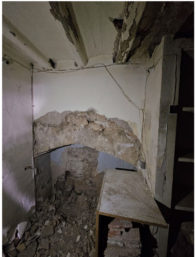
Arrancada d'arcada en planta baixa) i part central d'arcada (planta entresol)
