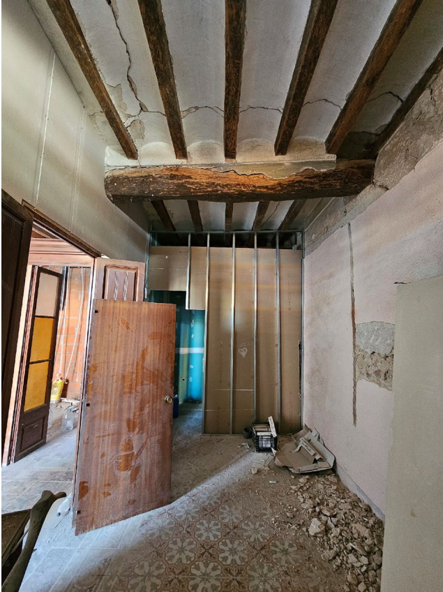
Planta primera. S'observen les obres de rehabilitació iniciades. Rajoles hidràuliques a recuperar
