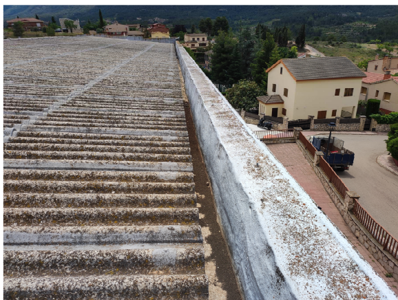
Detall canal recollida pluvials
