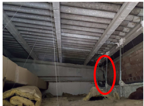
Vista cara inferior, detall baixant pluvials
