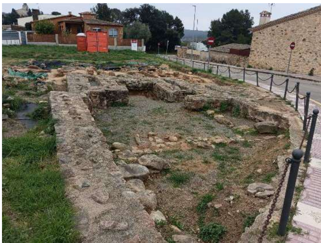
Murs penjats amb el fonament a la vista, vegetació als coronaments i als espais interiors. Coronament pla format amb morter, i línia de pedres centrals formant una cresta.
