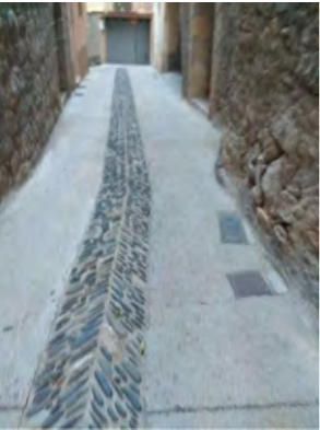
Paviment de còdols sobre base de formigó
