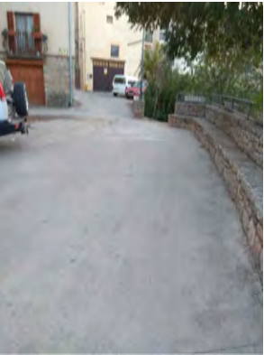
Paviment de formigó
