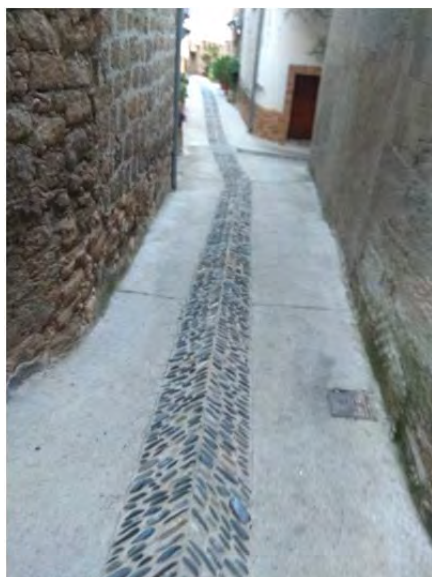
Imatge paviment existent
