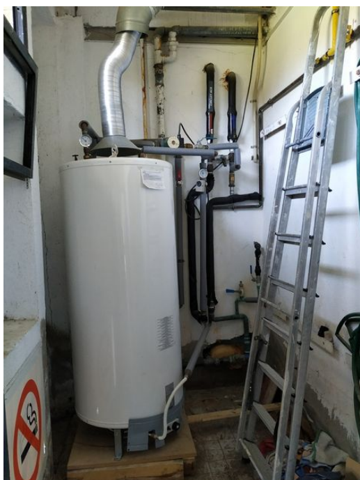
Imatges 3 i 4.- Dipòsit ACS i placa característiques
