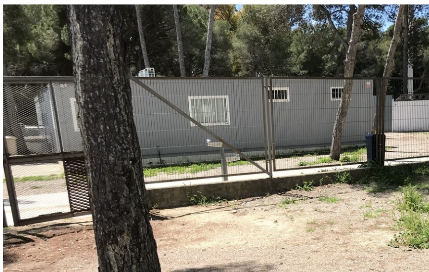
Imatge 8.- Exterior mòdul prefabricat oficines i magatzem
