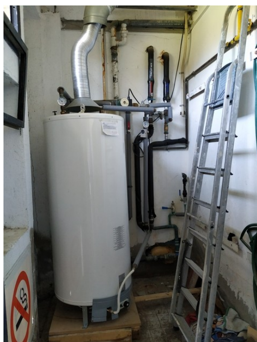
Imatges 3 i 4.- Dipòsit ACS i placa característiques
