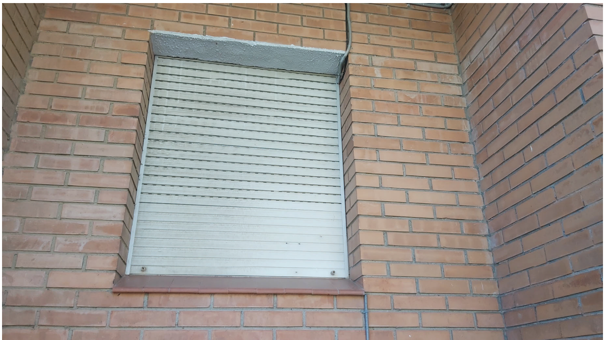
Imatges parcials i generals dels tancaments exteriors . façanes
