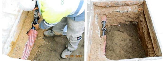
Croquis indicatiu de connexió de l'anell de degoteig a la canonada secundària per al reg de l'arbre
