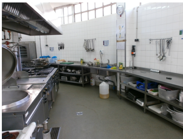
Mostrador de càrrega i pica de dos sens de 9 m de longitud total
