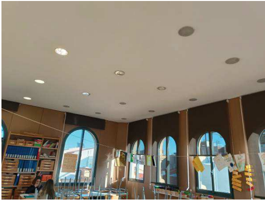
Sostre 6è primària – edifici c. Estrella
