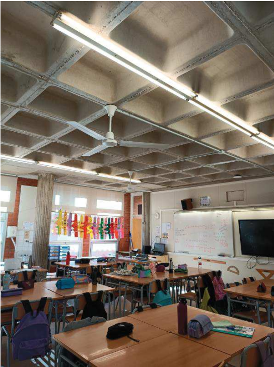
Ventiladors instal·lats - aula
