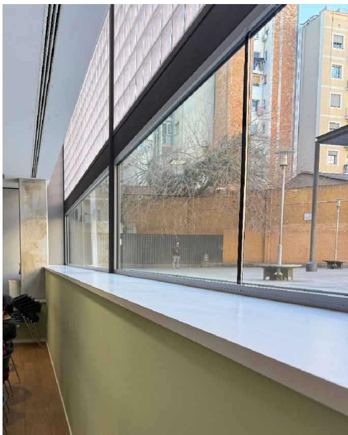
Tancament de façana vist de de l'interior. Repisa. Separació actual amb sala de reunions.
