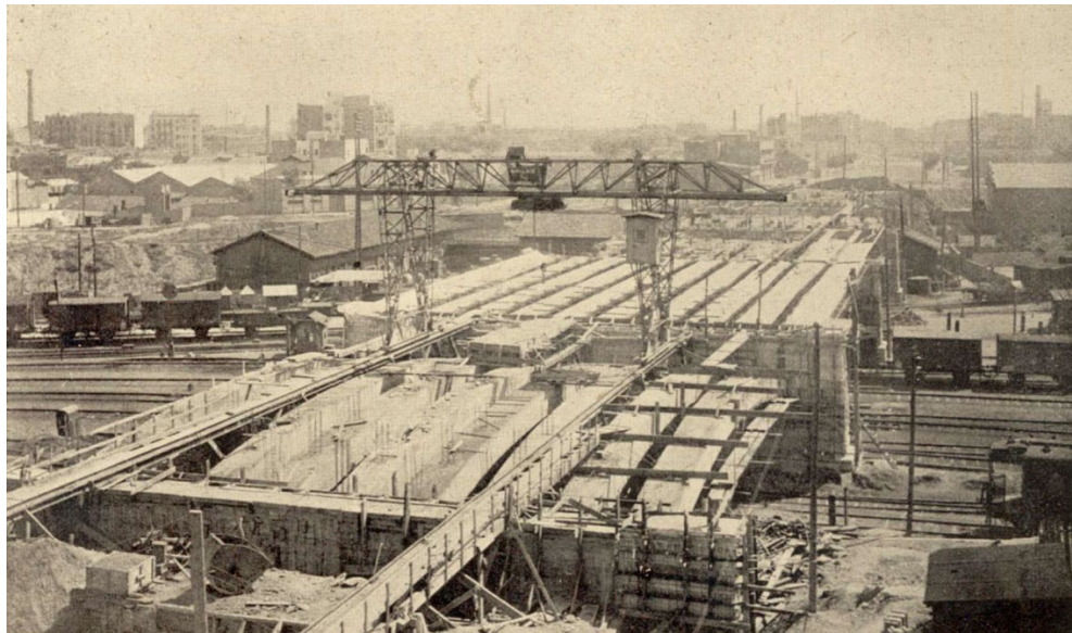
Fotografia històrica de la construcció del pont.
