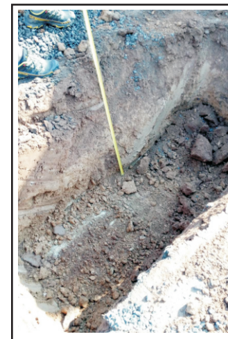
Vista de la cala realitzada
