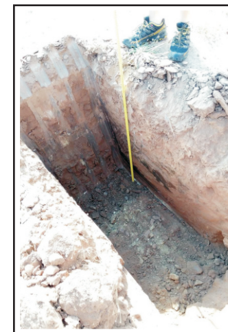
Vista de la cala realitzada
