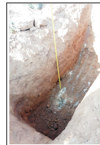
Vista de la cala realitzada
