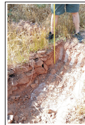
Vista de la cala realitzada
