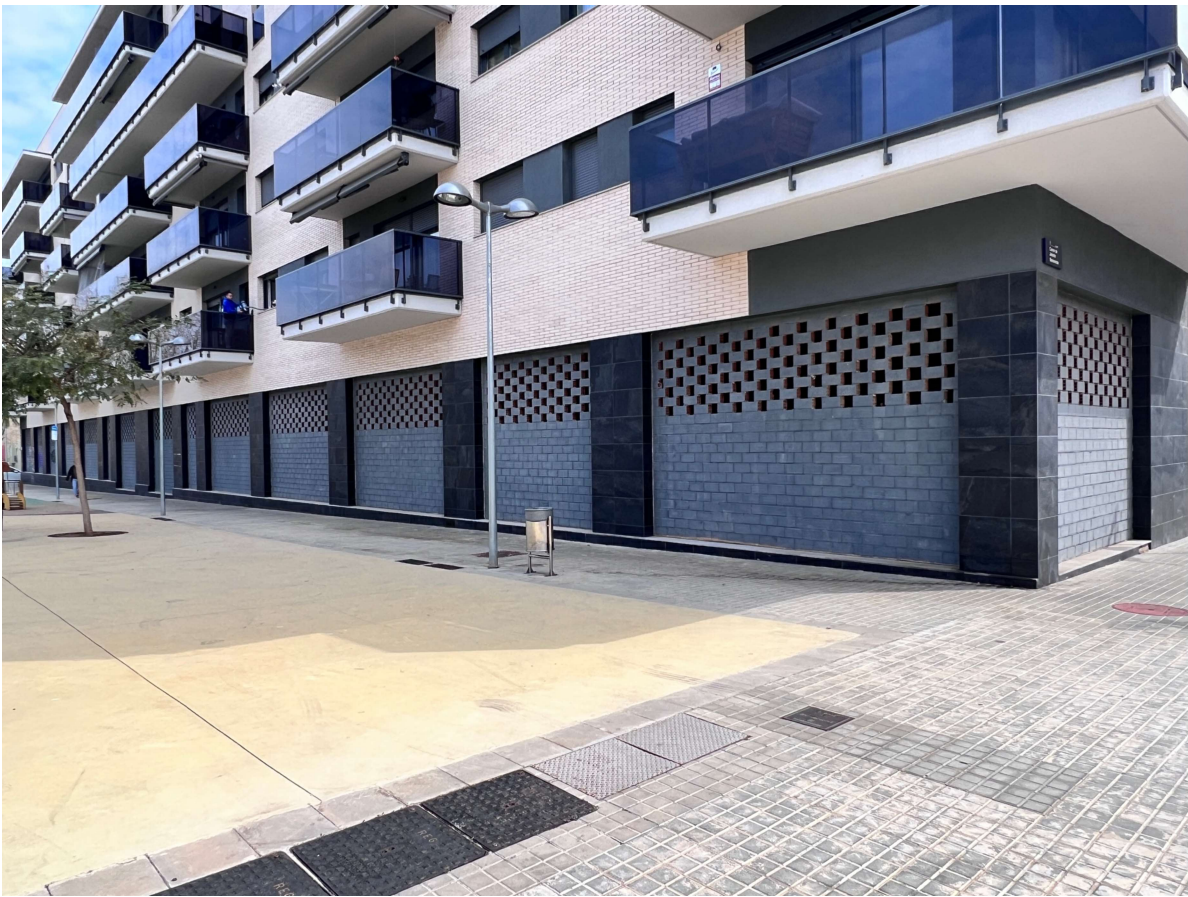
ESTAT ACTUAL - VISTA EXTERIOR
