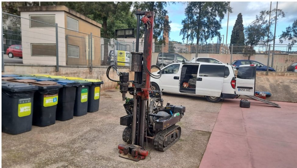
FOTO 1. LOCALIZACION PENETROMETRO P1.
