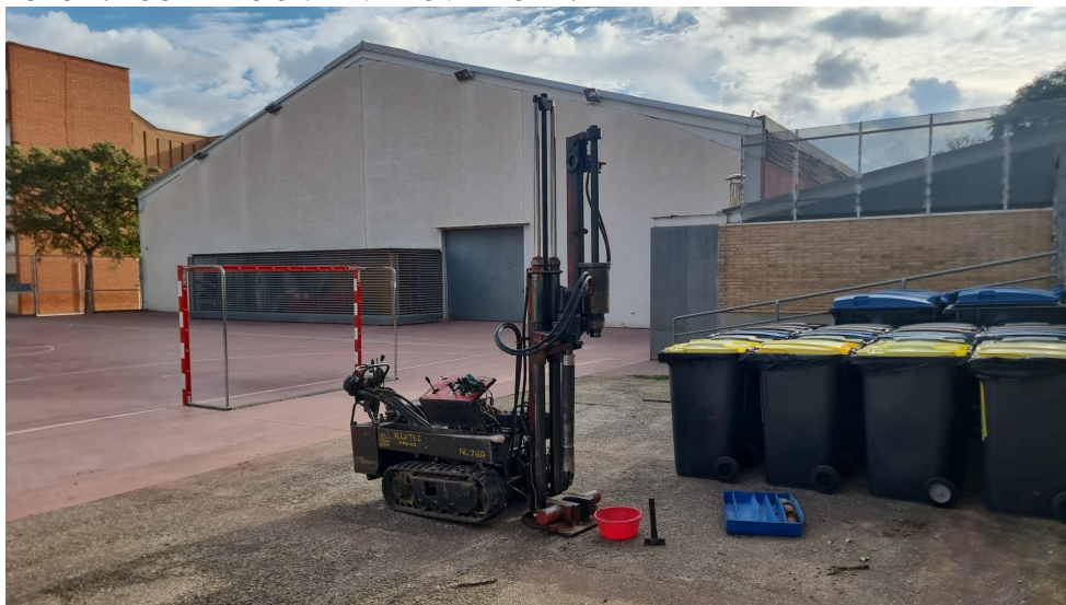
FOTO 2. LOCALIZACION PENETROMETRO P2.
