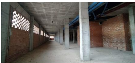
ESTAT ACTUAL - INTERIOR DEL LOCAL
