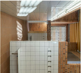
ACOBAT SUPERIOR D'OBRA DE FABRICA SENSE RECESTR
