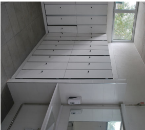
QUINETS DE PANELL FENOLIC LAMINAT DECORATIU D'ALTA PRESSIO TIPIUS COMPACTE O SIMILAR, DE 300x300mm
