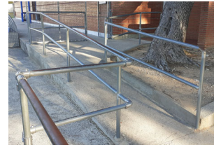
FOTOGRAFIA 1. BARANA EXISTENT DOBLE PASSAMÀ
