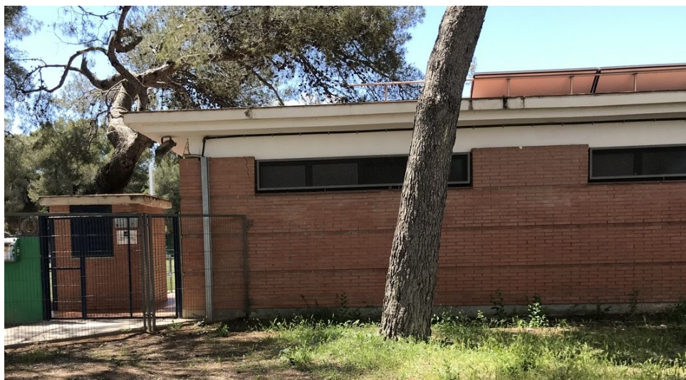
Imatge 6.- Exterior edifici Vestidors principal
