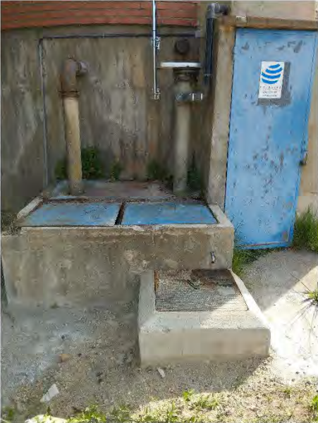
Detall de les arquetes del dipòsit.
