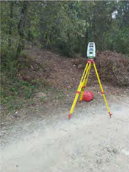
Base aixecament ampliació
