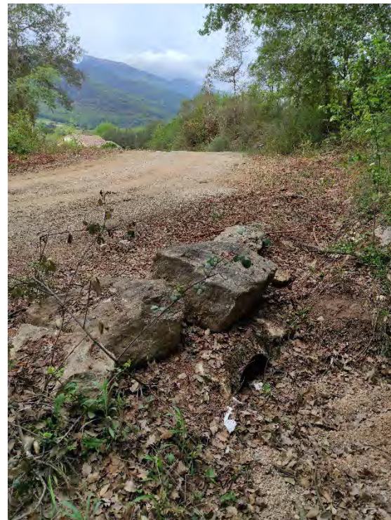
Fotografia 10. Drenatge del torrent de Pinyana
