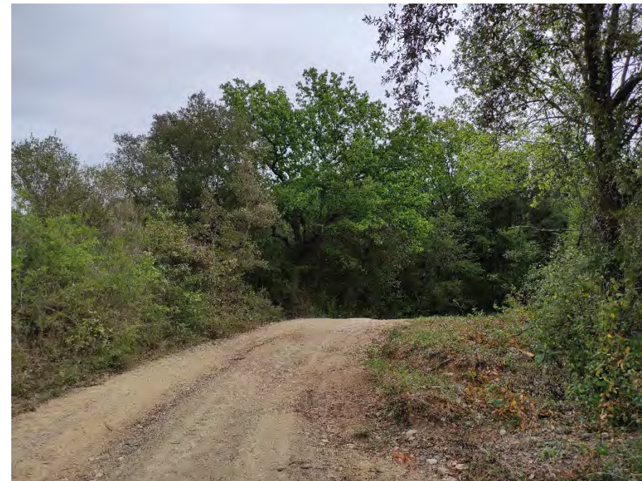
Fotografia 8. Camí d'accés al futur dipòsit
