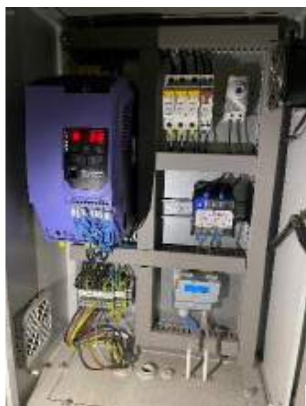
Fotografia 24. Variador de freqüència que es retirarà.
