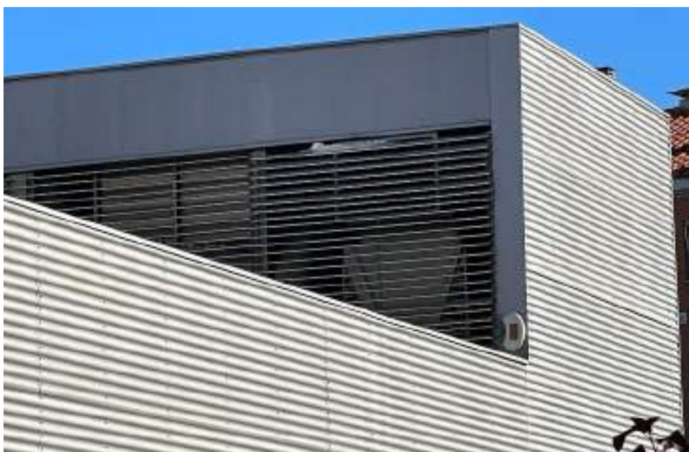
Fotografia 02. Detall façana en correspondència amb sala d'instal·lacions a planta sotacoberta. Zona que s'ampliarà.
