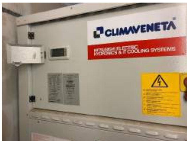
Fotografia 18. Detall 1 bomba de calor Climaveneta, model NX-N/K 0502P de Mitsubishi Electric que es manté i donarà servei als nous fancoils instal·lats.
