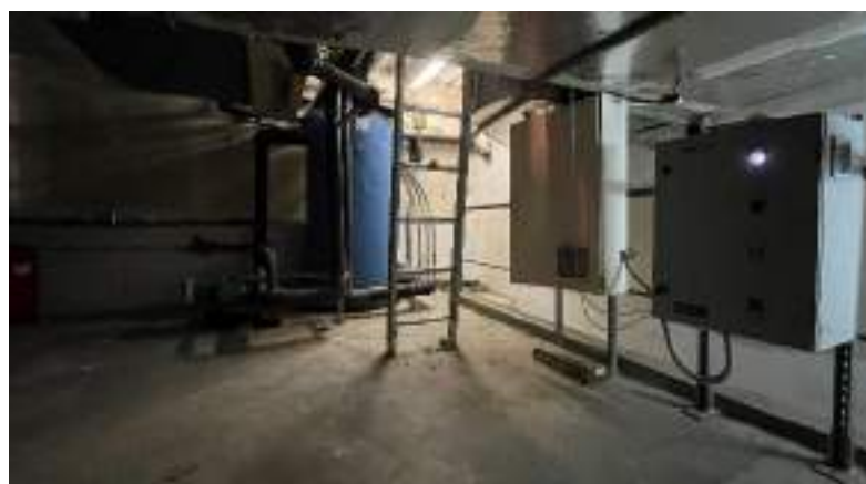
Fotografia 24. Variador de freqüència que es retirarà.
