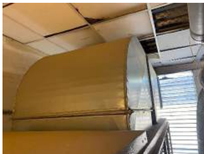
Fotografia 19. Detall 2 bomba de calor Climaveneta, model NX-N/K 0502P de Mitsubishi Electric que es manté i donarà servei als nous fancoils instal·lats.
