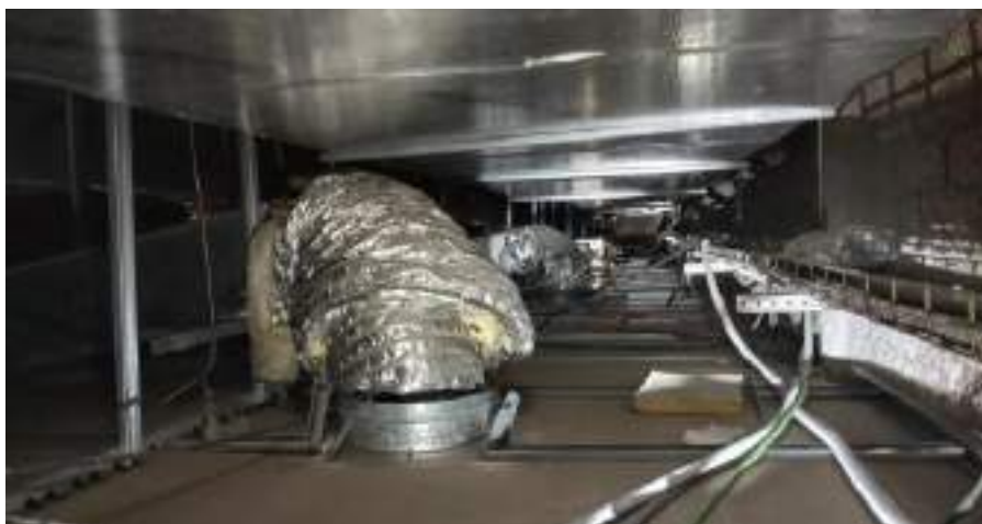
Fotografia 13. Conductes d'impulsió desconnectats fals sastre de la sala polivalent – Clara Simó.
