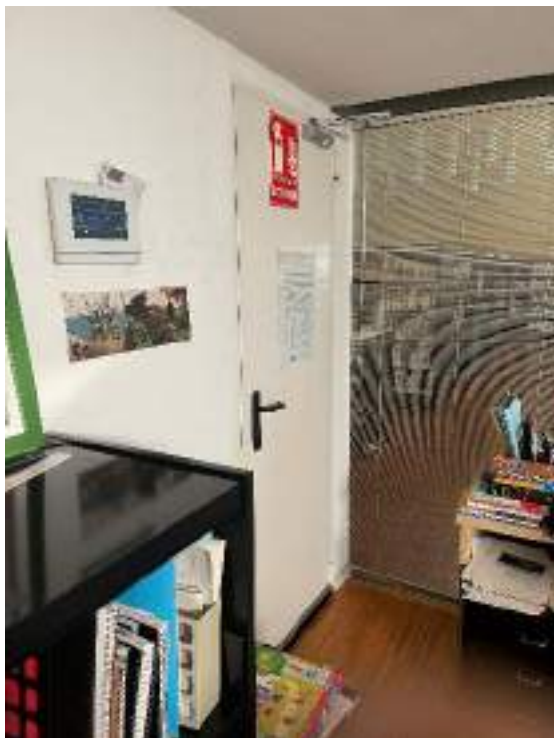
Fotografia 28. Porta d'accés a la sala d'instal·lacions.
