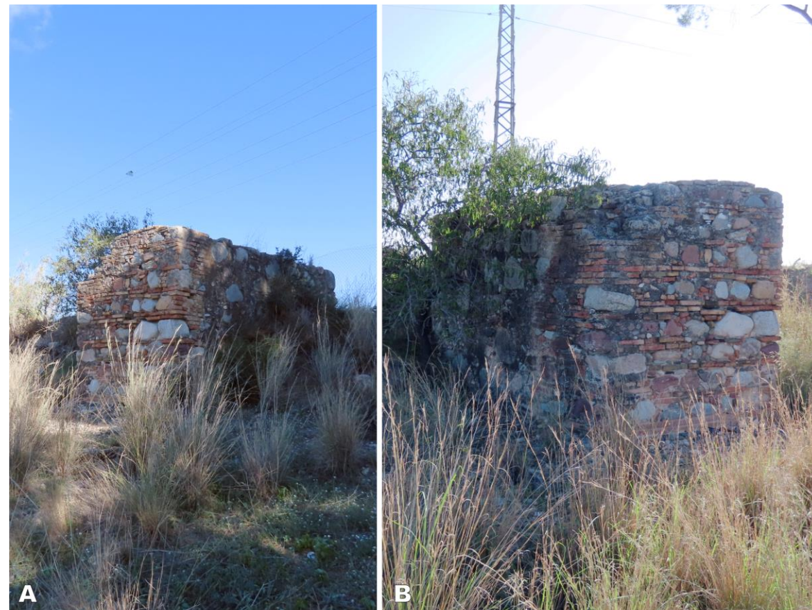
2. Estructura 2, ubicada al marge esquerre al límit amb la finca del Mas del Toda. Podria estar relacionada amb la gestió de les avingudes torrencials. Té una planta trapezoidal amb la part frontal (A, B) més estreta que la posterior (C). Al sostre, hi ha una base semiesfèrica de pedres i argamassa amb una estructura metàl·lica que sembla destinada a fixar-hi una barra.
