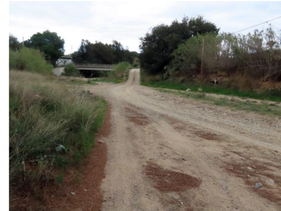
7. Vista del gual G11, cap al sud (esquerra, amb el pont de la T-310 al fons) i cap al nord (dreta).
