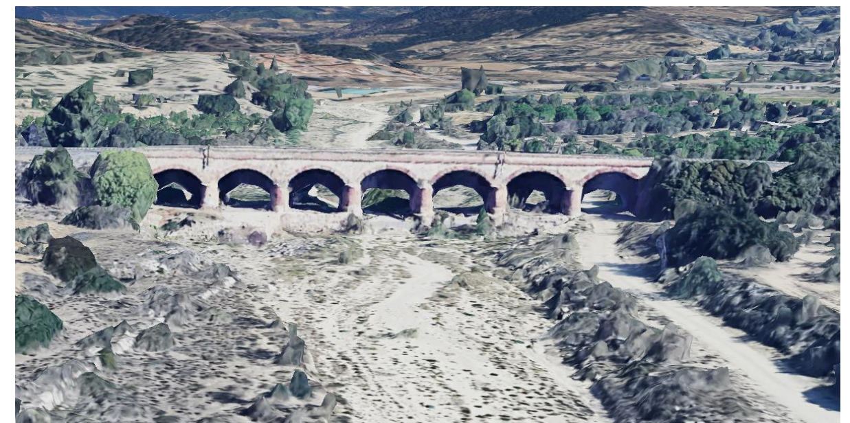
Figura 1. Pont de la línia fèrria FFCC Barcelona-Riba-roja (al límit municipal entre Riudoms i Maspujols), entre el 1900 i el 1914 (imatge superior), i en l'actualitat (imatge inferior; Font: Google Earth 3D). La llera actual, fortament incidida (el salt topogràfic aigües avall de la llosa de cimentació del pont és de 2,5m; veure Figura 4), contrasta amb la llera de principis del segle XX. En aquesta època el calaix fluvial estava reblert de material al·luvial, de tal manera que la llera es trobava amb una relació topogràfica estreta (a molt poca distància) de la plana d'inundació.
