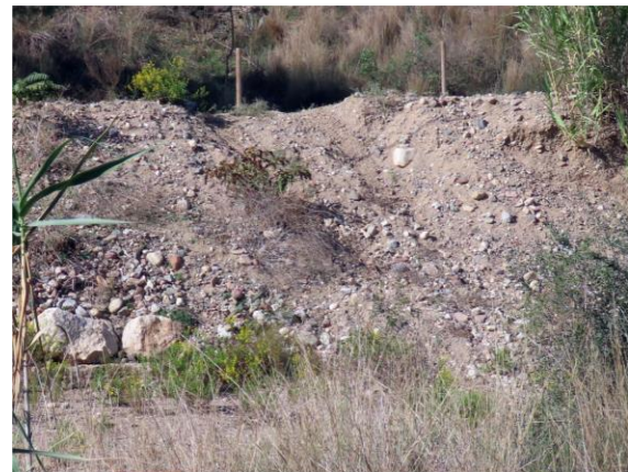
8. Accés/sortida de vehicles motoritzats a la llera de la riera. S'ha obert sobre el talús de protecció executat arran de la DANA d'octubre de 2019.
