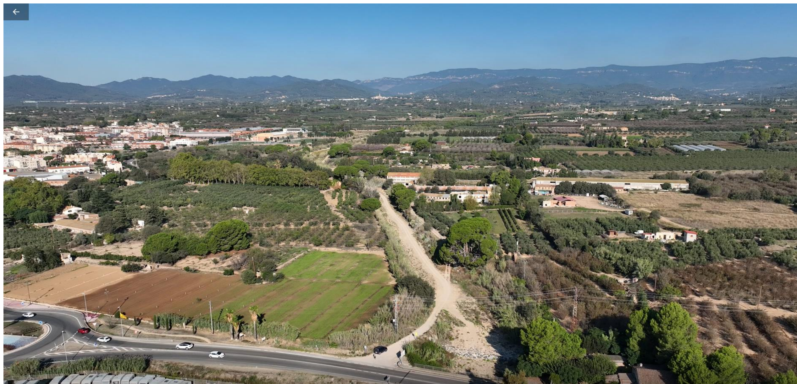
Panoràmica 1. Inici àmbit de projecte direcció aigües amunt
