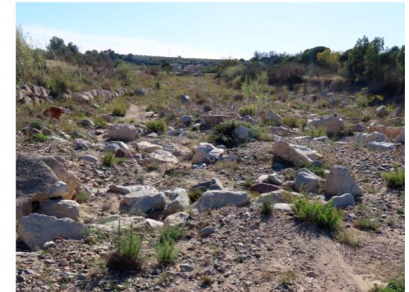
4. Blocs d'escullera despresos d'antigues estructures envaint la llera, entre la N-420 i el Pont de la Via.
