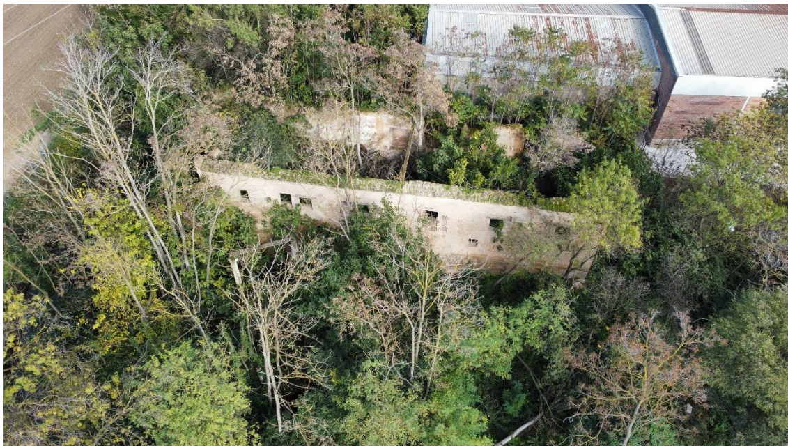
Foto edifici existent, amb els arbres a talar.
