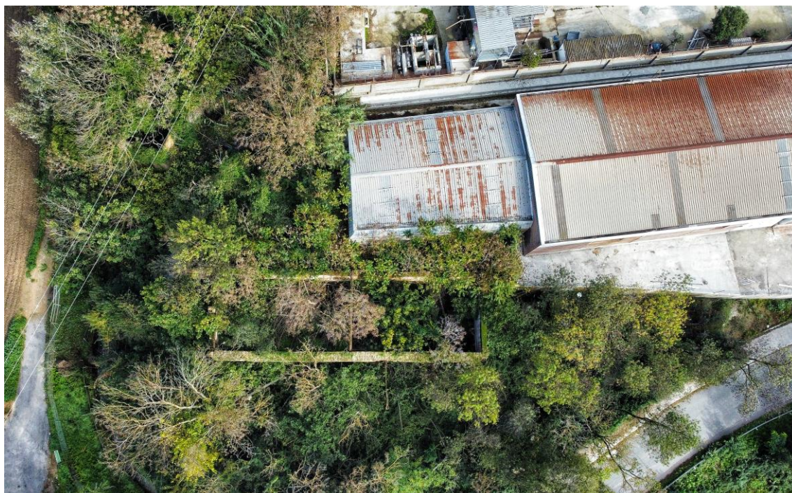
Foto aèria de l'àmbit d'actuació
