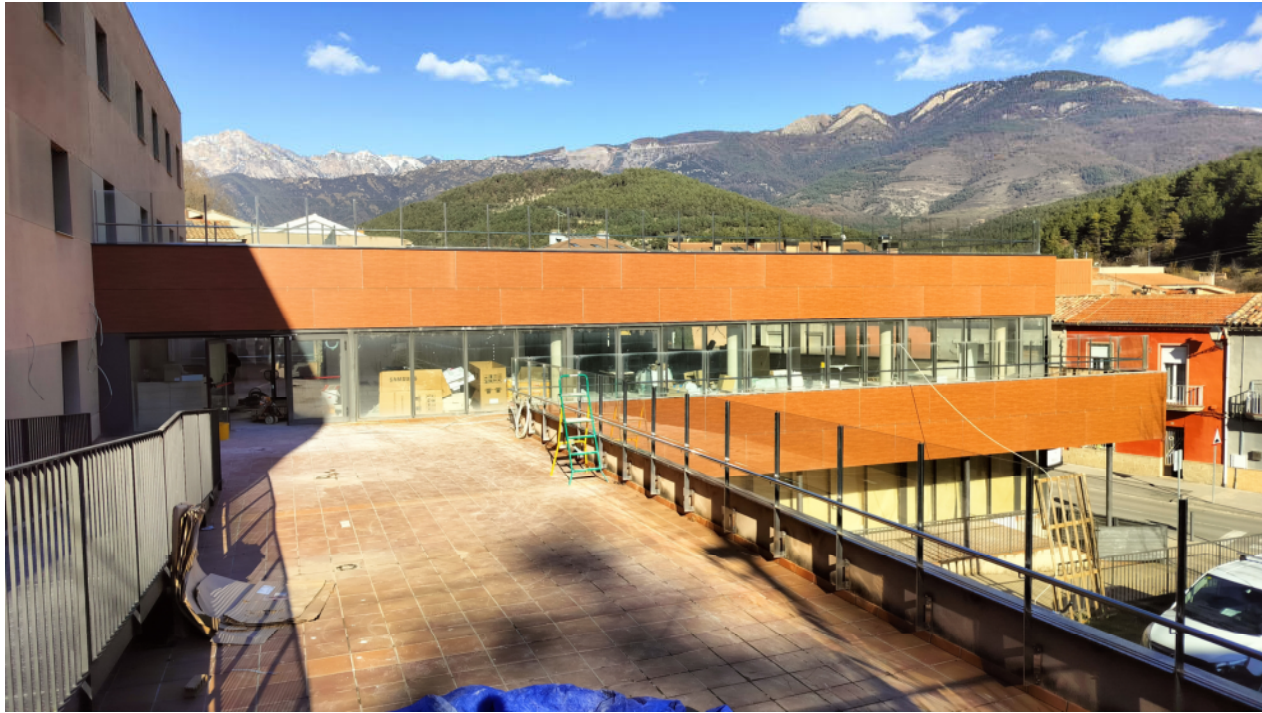
FOTOGRAFIA ESTAT ACTUAL | ZONA D'ACTUACIÓ
