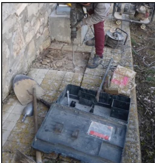
Fotografia 6. Vista de la cala manual C-1.
