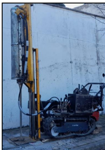
Fotografia 5. Detall de la màquina de sondeig utilitzada per a la realització de l'assaig de penetració dinàmica DPSH P-1.
