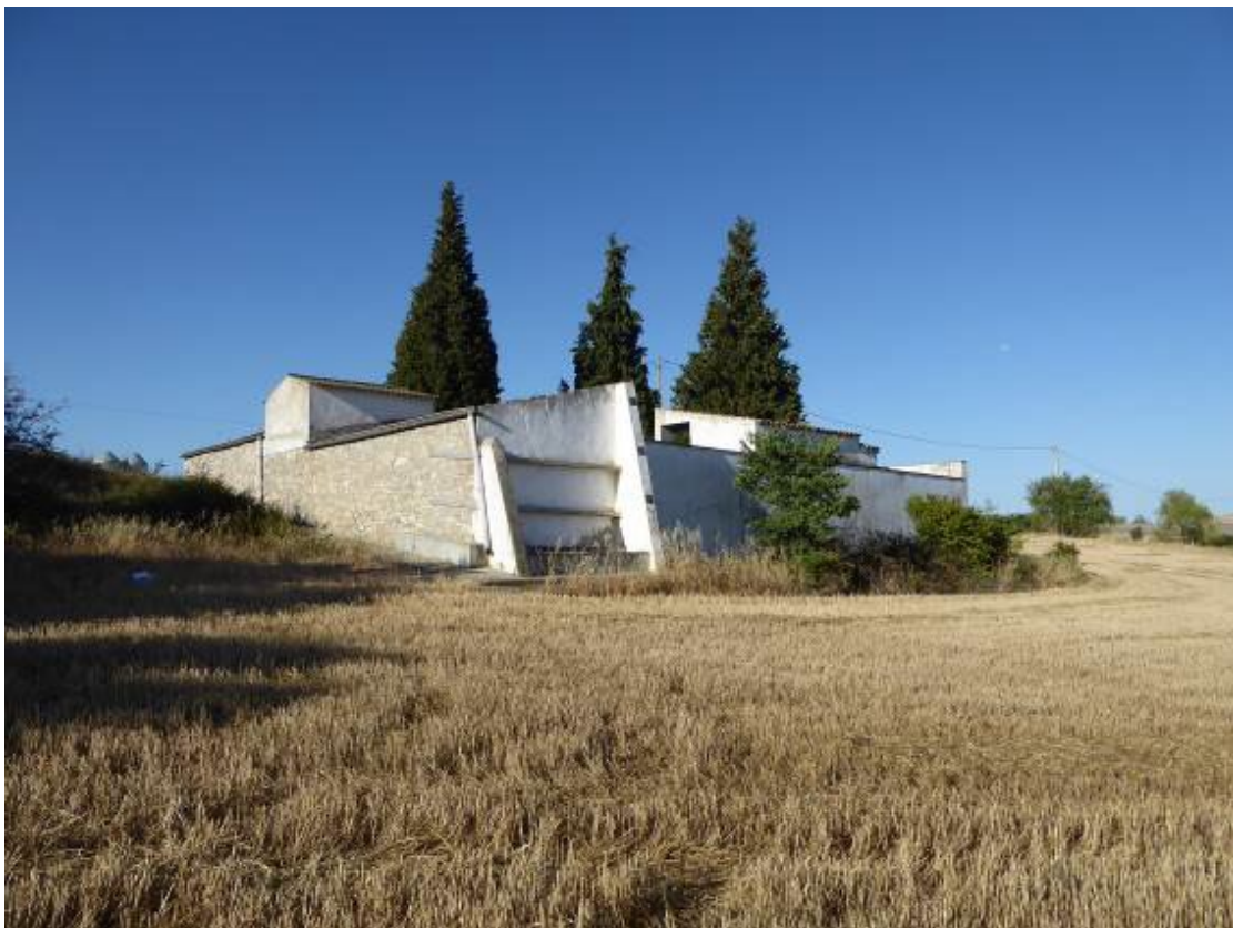
Vista general del cementiri desde la cantonada nord-est
