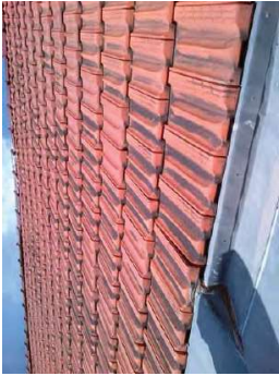
Imatge 3. Coberta de teules ceràmiques
