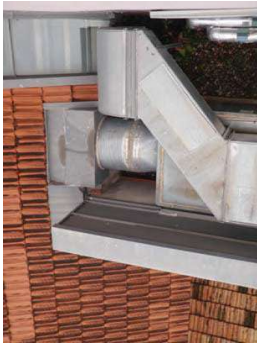
Imatge 10. Coberta de teules ceràmiques. Pas d'instal·lacions
