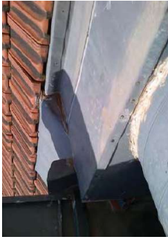
Imatge 5 Coberta de teules ceràmiques. Pas d'instal·lacions
