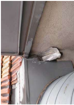
Imatge 6 Coberta de teules ceràmiques. Pas d'instal·lacions
