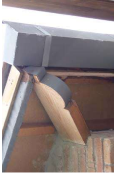
Imatge 15. Coberta de teules ceràmiques, Ràfec
