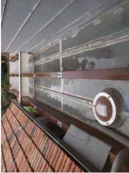
Imatge 4. Coberta de zinc
