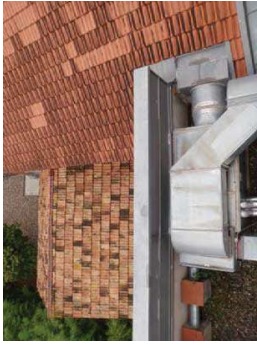
Imatge 9. Coberta de teules ceràmiques. Pas d'instal·lacions
