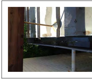
DETALL BIGA I TIRANT EXISTENTS
