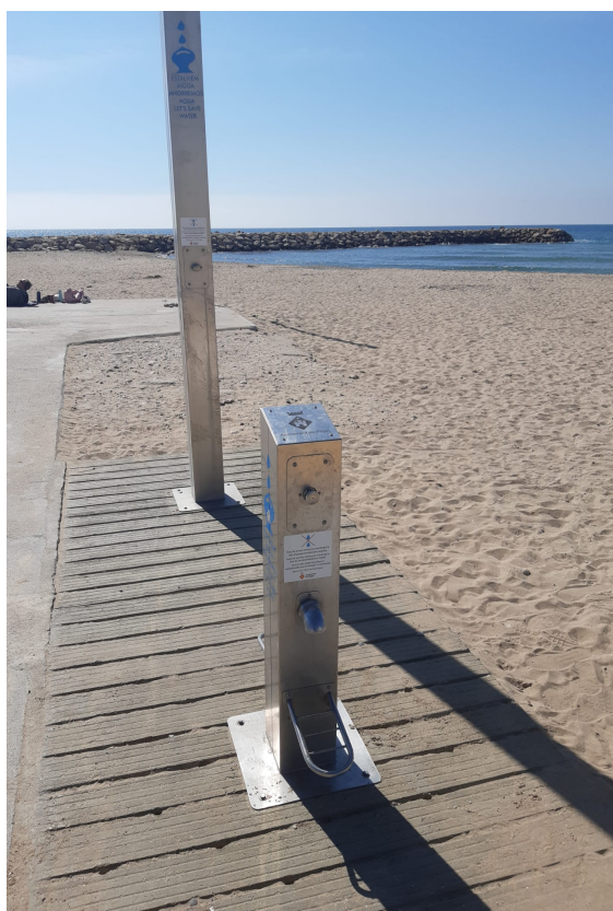
Dutxa i rentapeus d'acer inoxidable sobre base de formigó.
