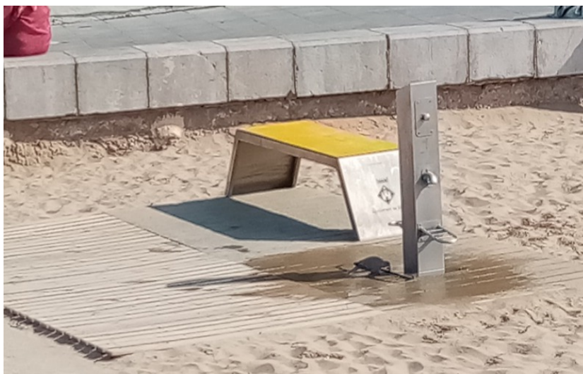
Banc i rentapeus d'acer inoxidable sobre base de formigó.
