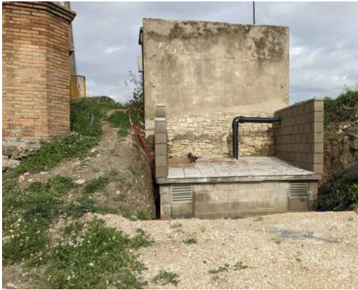
Il·lustració 7: Cambra del col·lector acabada
