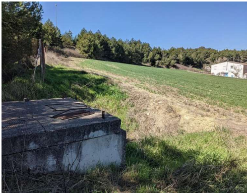
Il·lustració 11: Pou nord d'entrada a la galeria
