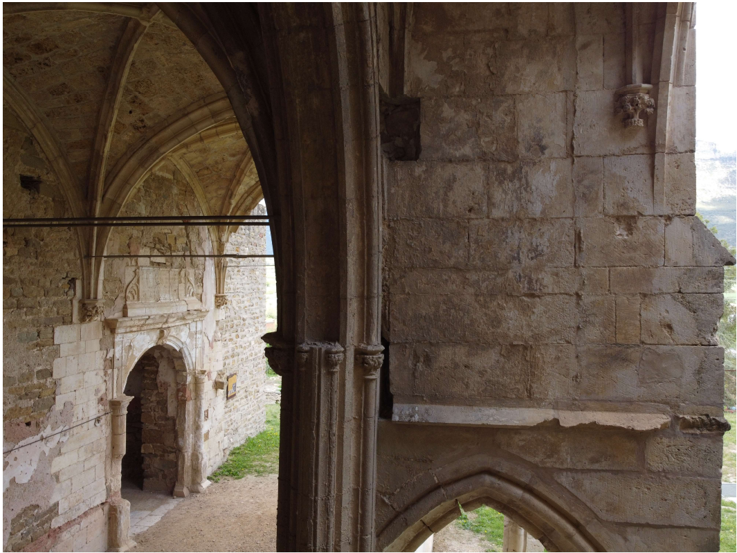
Contrafort 1 de la galeria exterior, situat entre el 2on i 3r tram
