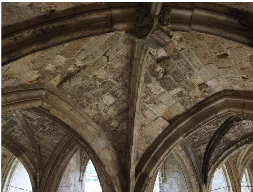
Parament vertical sud, plementaria, arcs i clau de volta corresponent al 1er tram
