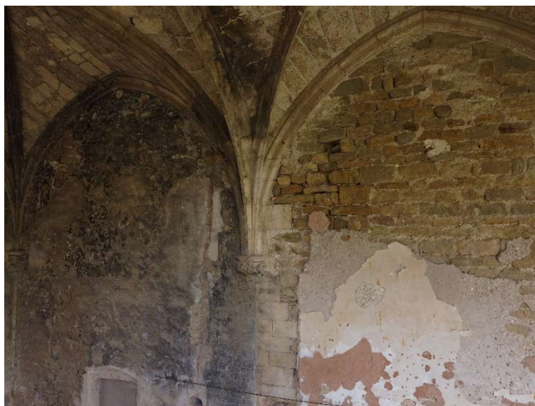
Parament vertical oest. Fàbrica i revestiment corresponent al 1er i 2on tram
