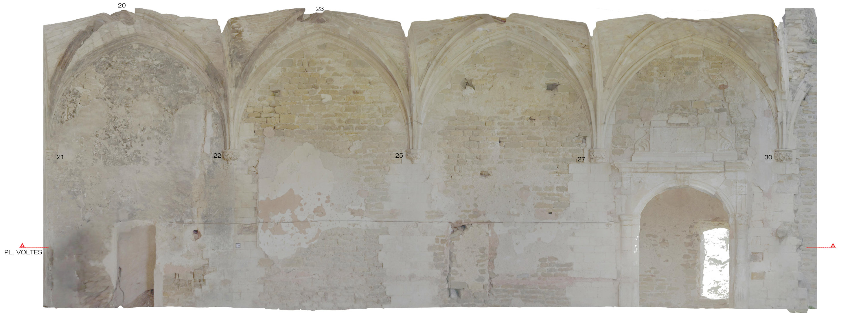
ALÇAT PARAMENT INTERIOR OEST
