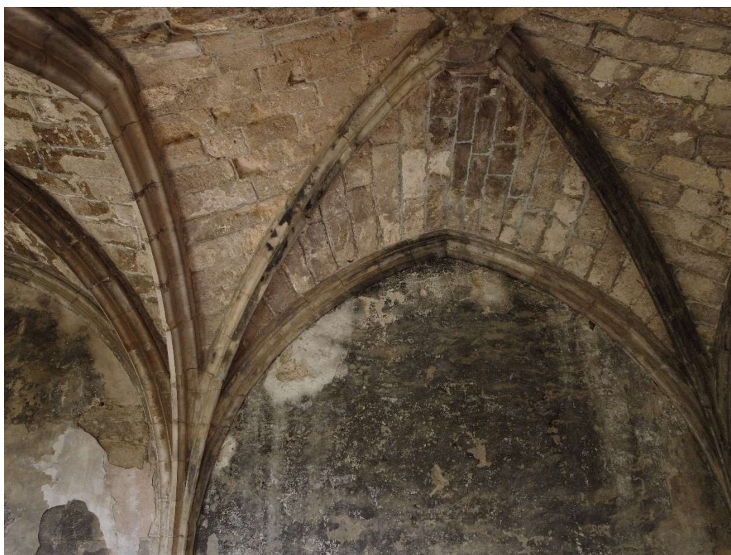
Parament vertical sud, plementaria, arcs i clau de volta corresponent al 1er tram
