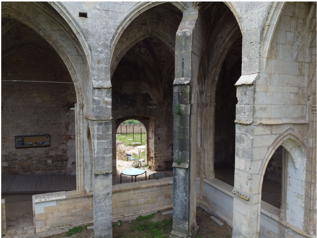
Contrafort de cantonada de la galeria exterior
