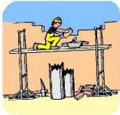
Fig. 11: Falta de orden y limpieza
