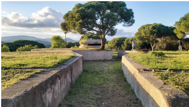
Interior dels murs del parc cap al búnquer
