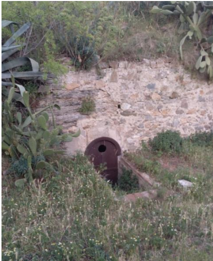
Accés tram sud
