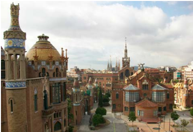
09. Vista de l'interior del Subsector C, Passeig Central
