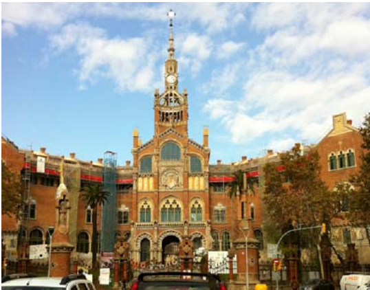
07. Vista de l'accès principal
