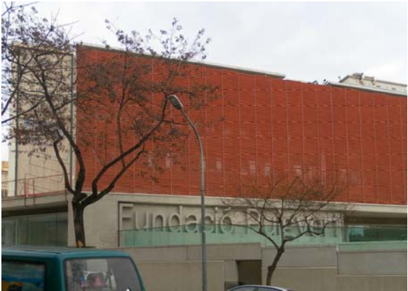
04. Vista de l'accès principal
