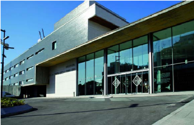
01. Vista de l'accès principal
