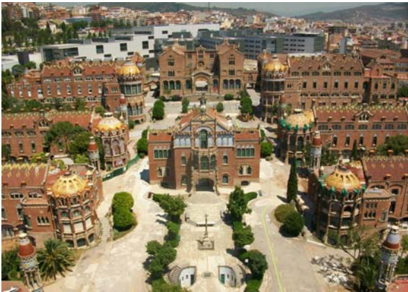
08. Vista de l'interior del Subsector C, Passeig Central
