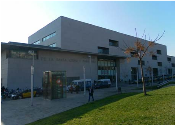
02. Vista de l'accès carrer Mas Casanovas
