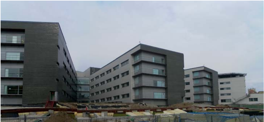
03. Vista de l'interior del Subsector A
