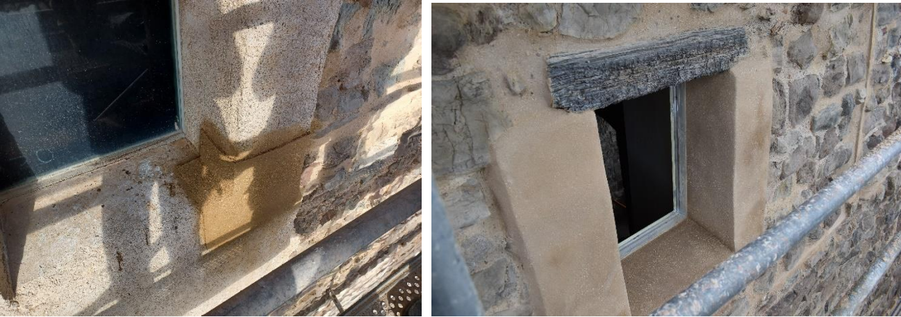
Els ampits de finestra també es resoldran morter, amb un acabat hidròfug.
