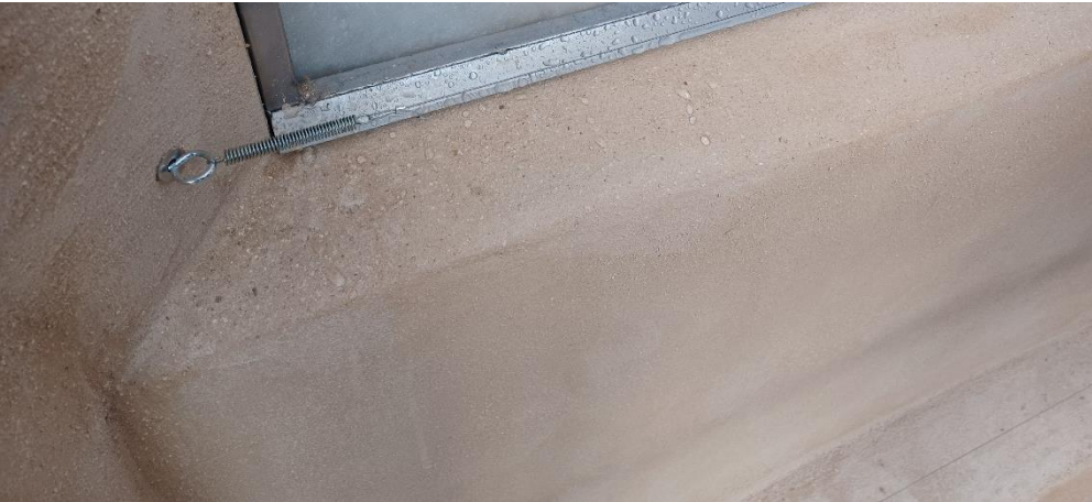
Els ampits de finestra també es resoldran morter, amb un acabat hidròfug.
